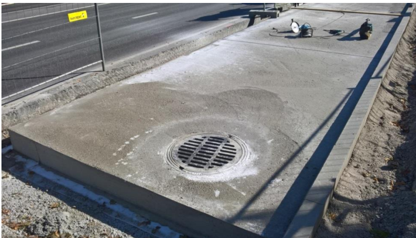
Foto 6. Valminud Endla betoonkattega bussipeatus 2017.a.. Restkaevu päis on valatud betoonkatte sisse.
