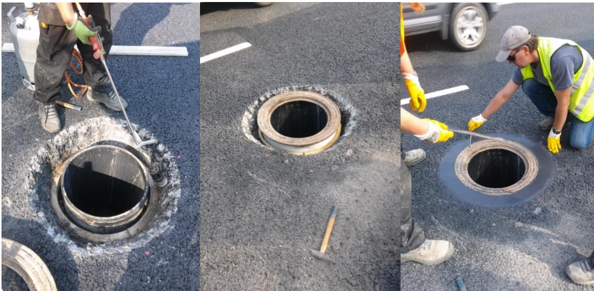
Fotod 8-10. Lahti piigatud kaevupäis, luugikorpus on eemaldatud. Gaasipõletiga soojendatakse asfaldipinda enne Vergumix segu paigaldamist. Luugikorpus paigaldatud. Kaevupäise ümbruse täitmine Vergumix-seguga (2014)
