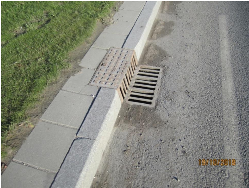
Foto 47. Osaliselt rentsliis paiknev neeluluuk paigaldatakse kas jäigale betoonist kaevule või plastkaevu teleskooposale. Suur-Sõjamäe tn
