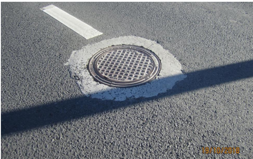
Foto 20. Suur-Sõjamäe 2018.a. Kaevupäise ümbrus täidetud Densifaltiga. Densifalt on pragunenud.
