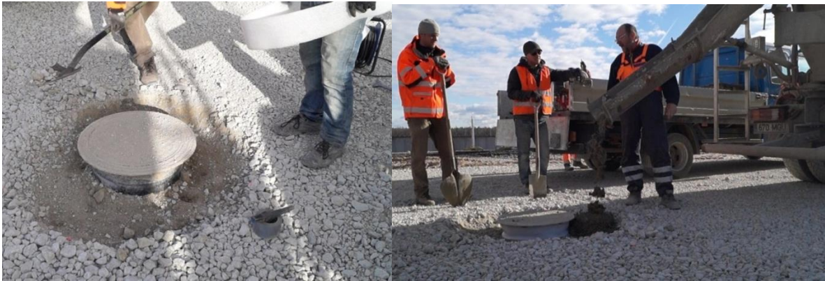
Fotod 13 ja 14. Suur-Sõjamäe tn kaevupäise ümbruse lahtikaevamine (2015) ja kaevupäise koormusjaotusplaadi valamine
