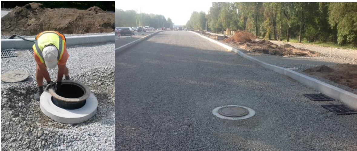
Fotod 6 ja 7. Koormusjaotusplaadi paigaldamine - Ehitajate tee (2014) ja paigaldatud plaat tihendatud killustikaluses
