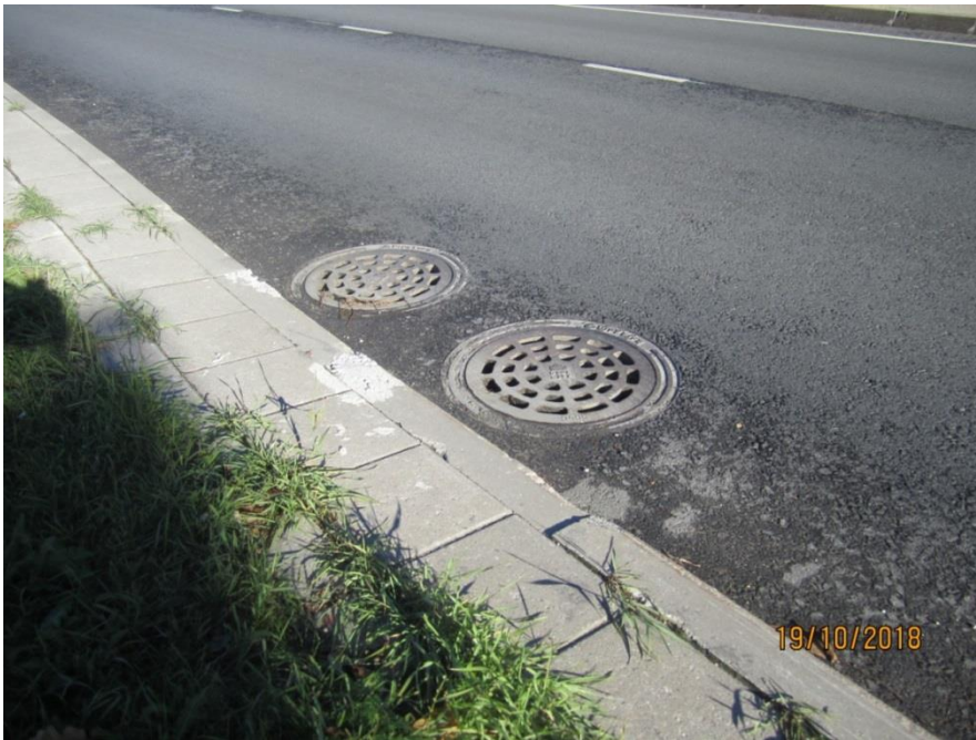
Foto 46. Ümmarguse restkaevuluugiga kaevud Merivälja teel
