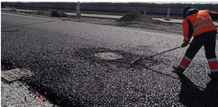
Foto 17. Suur-Sõjamäe kaevuümbruse asfalteerimine-2 (2015)
