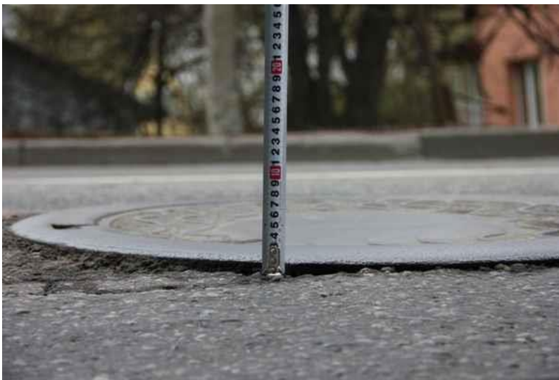
Foto 43. Kaevupäis on tänava kattest kõrgemal 15mm
