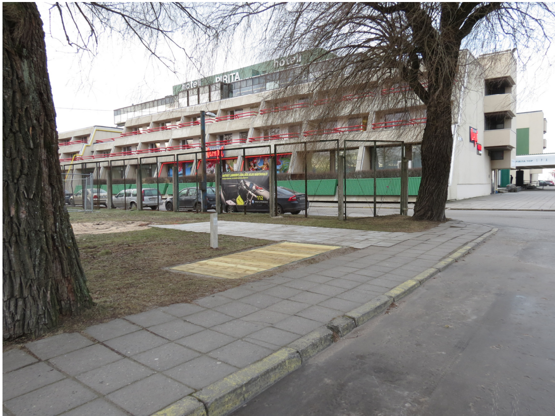
Foto 11. Pirita reeperite kamber peale katte uuendamist 2016.a.
