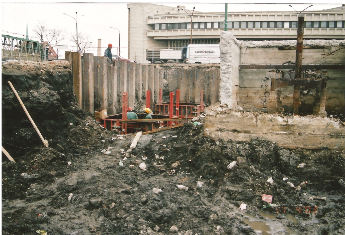
Foto 2. Viru reeperite kamer Viru keskuse ehitamise ajal.
