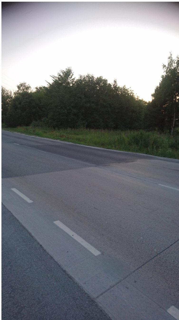
Foto 1.12.2. Asfaltlõigu katendiparand liitumiskohas betoonte rambiga.
