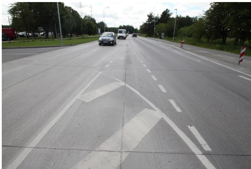
Joonis 8.2. Betoonkatte pikivuuk
