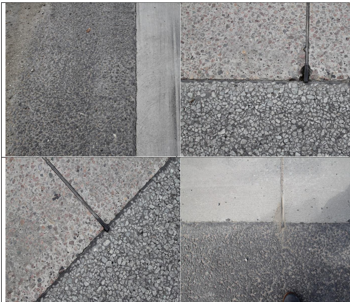
Joonis 8.3. Betoonkatte ja asfaltbetooniga tugevdatud peenra ühenduskohad
