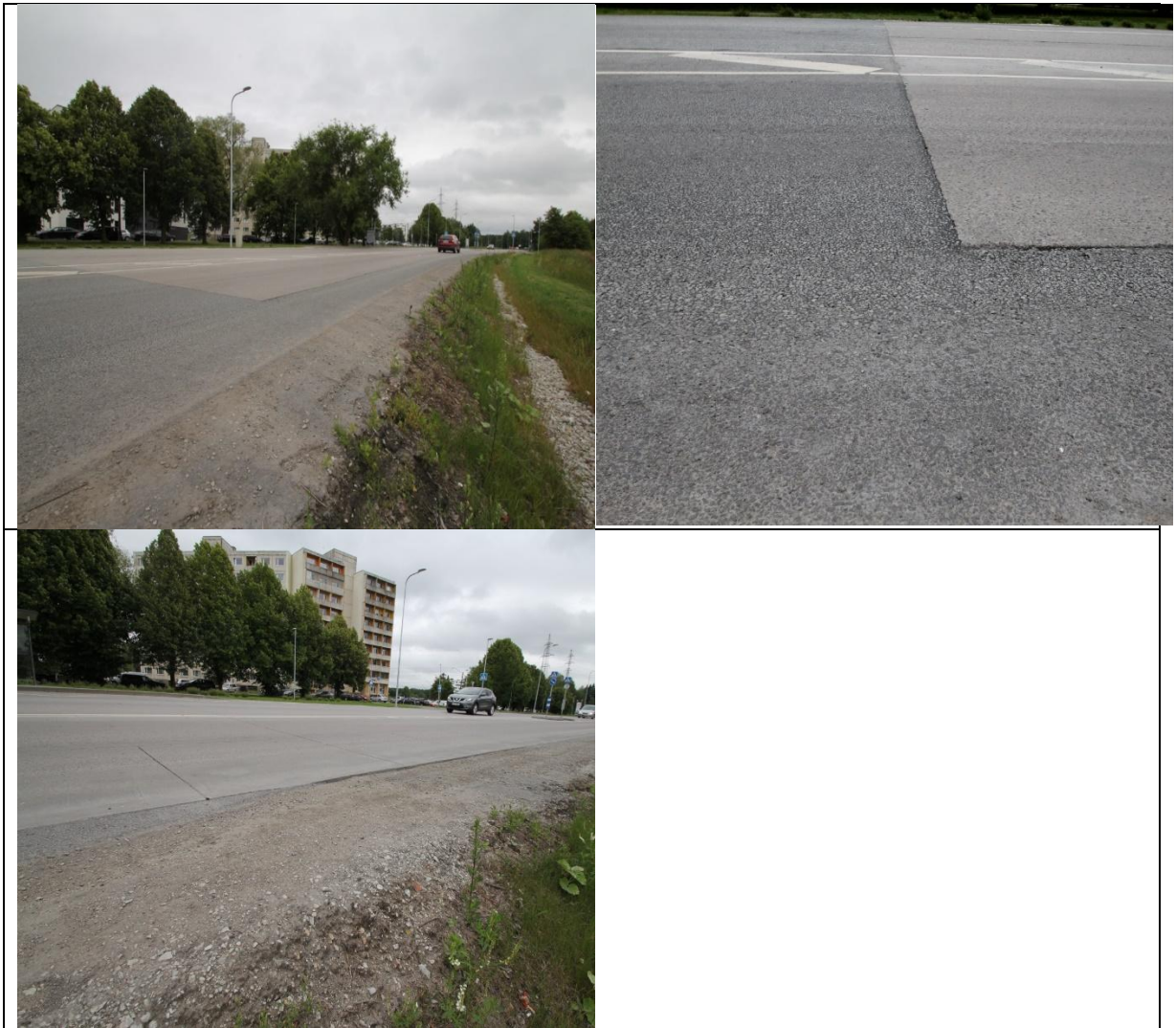
Joonis 8.4. Teepeenra äravajumine linnast väljuval suunal pk 6+70 kuni pk 6+20
