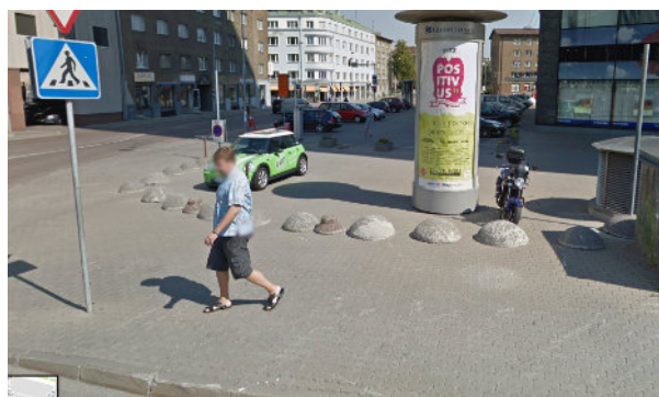
Erinevate betoonkupleite reostus Rõõmakuu puiesteel.
