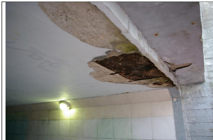
Vee lekked põhjustavad armatuuri roostetamist
