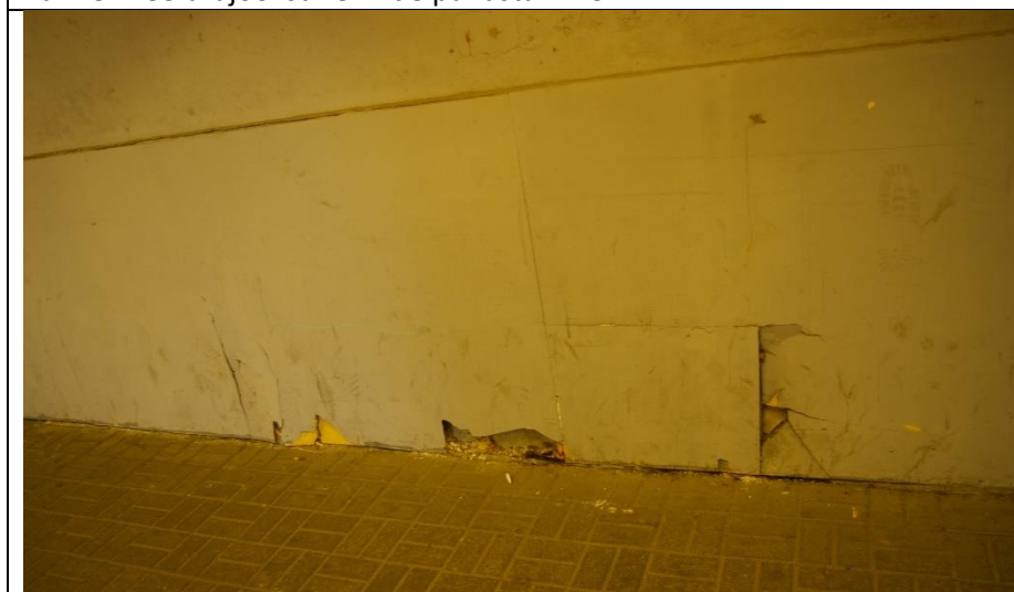
Tunneli seinakatte taastamine
