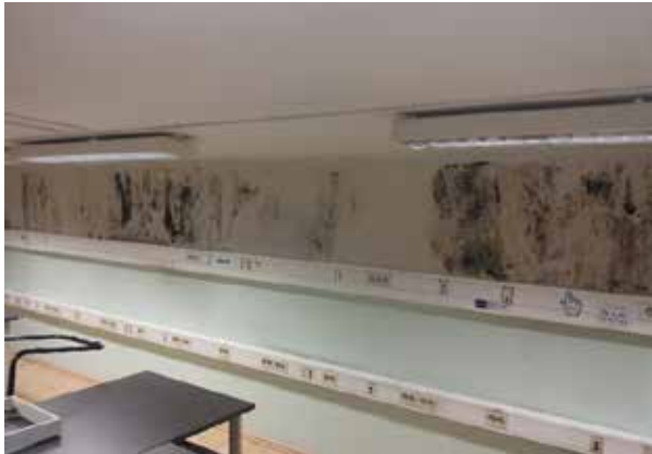
Joonis 2 Vasakul: hallituskahjustustega välisseina sisepind enne lisasoojustuse lammutamist (foto allikas: tellija). Paremal: juhtmete läbiviiguga aurutõkkele tekitatud ava on põhjustanud õhulekkeid ning võimalikke niiskuskahjustusi soojustusse.
