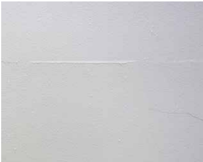
Joonis 17 CaSi soojustuse viimistluspahtlisse soojustusplaatide vuukidega kohakuti tekkinud praod.
