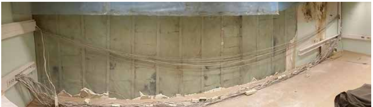
Joonis 3 Välisseina sisepind eelneva seespoolse lisasoojustamise lammutamise ajal (foto allikas: tellija).
