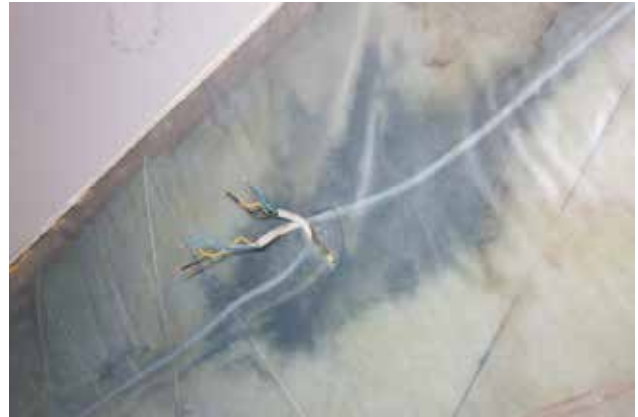
Joonis 2 Vasakul: hallituskahjustustega välisseina sisepind enne lisasoojustuse lammutamist (foto allikas: tellija). Paremal: juhtmete läbiviiguga aurutõkkele tekitatud ava on põhjustanud õhulekkeid ning võimalikke niiskuskahjustusi soojustusse.
