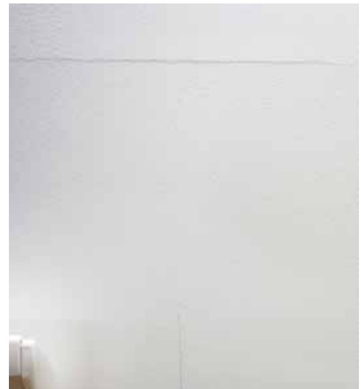
Joonis 17 CaSi soojustuse viimistluspahtlisse soojustusplaatide vuukidega kohakuti tekkinud praod.
