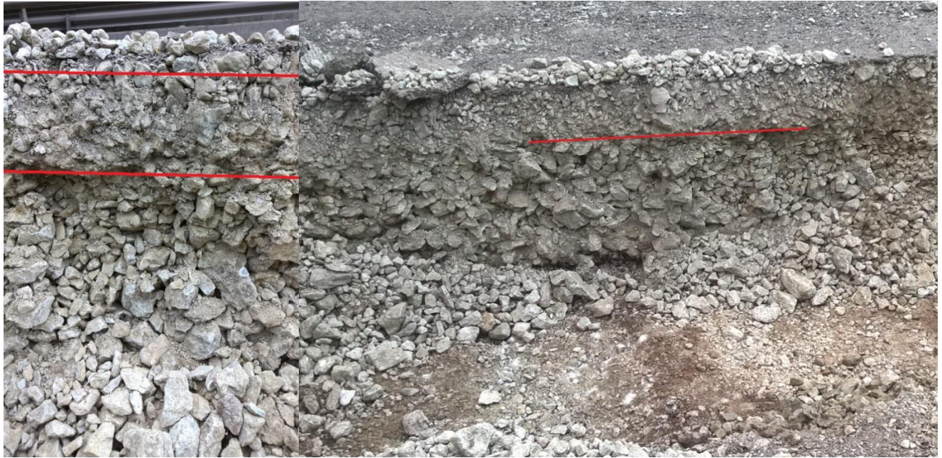
Joonis 15. Killustikalus on justkui kahes osas – pealmises osas on visuaalsel hinnangul suure savi ja peenosisesisaldusega materjal, suured killustikutükid on purunenud või lagunened.
