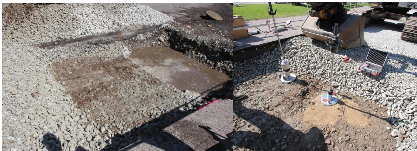
Joonised 10 ja 11. Eemaldatud killustik ja selle all paiknenud huumuse, liiva ja killustiku segu.
