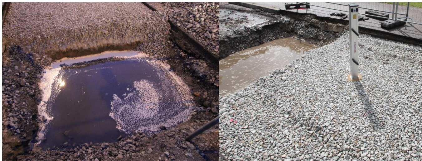
Joonised 6 ja 7. Öösel täitus kuna põhi veega, mistõttu ei olnud võimalik mõõtetöödega jätkata samast kohast ning need nihutati eemale. Jooniselt nähtub Inspector III uuest mõõtetööde asukohast.
