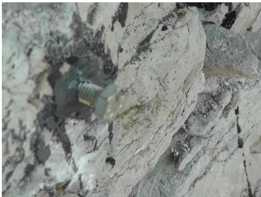
Joonis 18. Tehnika ja Kanali tee ristmiku läheduses paikneva Kaitsevæe kalmistu müüri tänavapoolsele küljele paigaldatud ajutine reeper (tähistus SR1)
