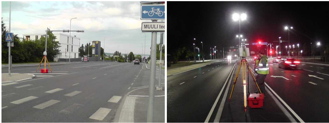
Joonis 1. Ranna tee ja Muuli tee ristmiku (vasakul) ning Ehitajate tee ja Õismäe tee ristmiku (paremal) terrestriline laserskaneerimine
