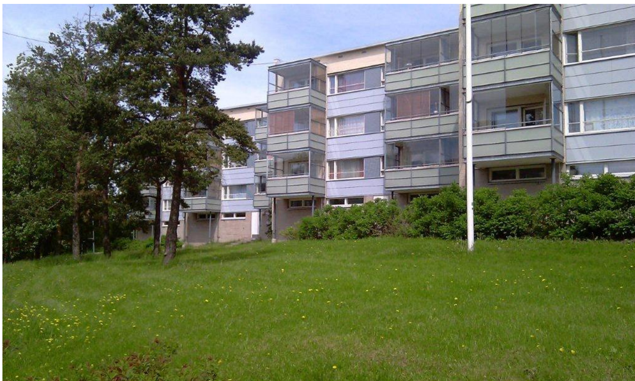
Jakomäki esimene elamu rekonstrueerimine 1995 - uus kinniehitatud rõdude süsteem
