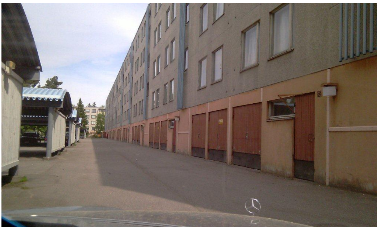
Jakomäki lammutamisele minev elamu, ebaefektiivne I korruse kasutus
