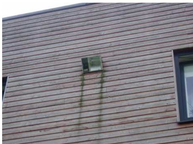
Joonis 10.2 Hoone laudise niiskuskahjustused.
