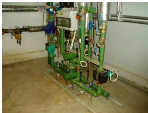
Joonis 23.2 Maleva 2a soojussõlm
