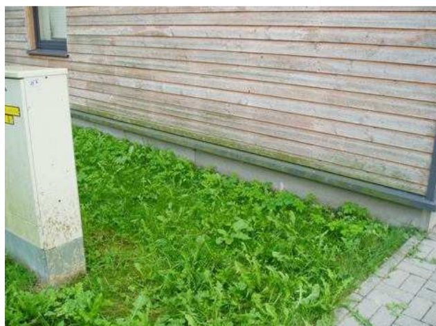
Joonis 10.2 Hoone laudise niiskuskahjustused.
