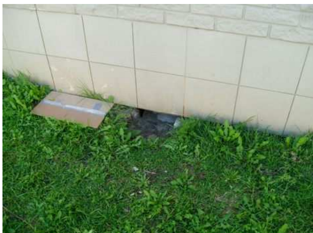
Maja ääres esineb pinnase vajumist ning ühes kohas kassidele auk keldrisse, kus taga paistab ka veetoru.
