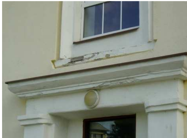
Joonis 12.3 Krohvikahjustused.
