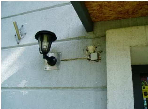
Välisvalgustuse paigaldamisel ei ole fassaadikate taastatud.
