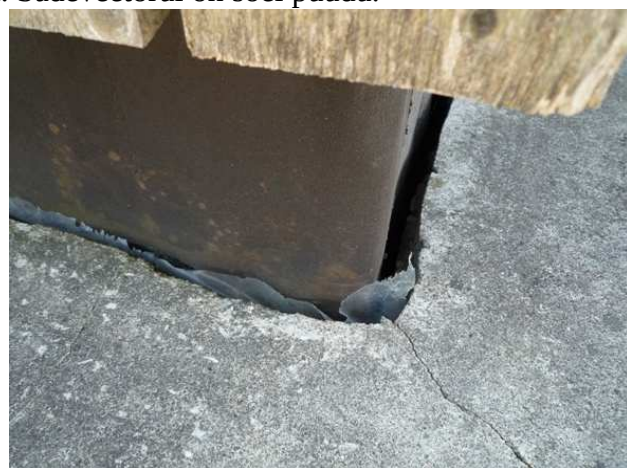
Betoonist (praguline) katuseosa. Sadeveetorul on sõel puudu.
