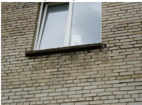
Aknaplekk on eemaldatud. Telliskivi vuugid ebatihedad.
