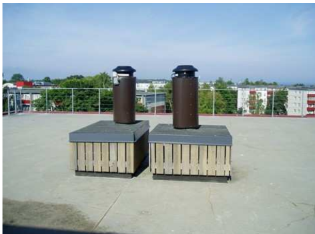
Joonis 2.3 Erika 9 katuseventilaatorid.
