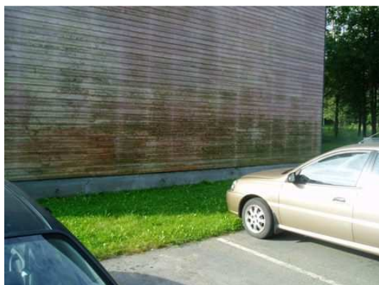
Joonis 11.2 Hoone laudise niiskuskahjustused.
