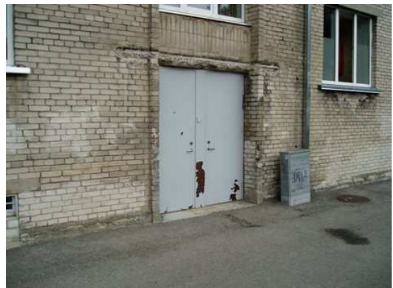
Eemaldatud varisemisohhtlik varikatus. Välisuksel värvikahjustused ja uks roostetab.
