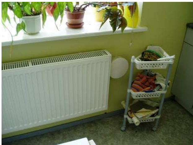
Joonis 12.2 Värskeõhuava seinas.
