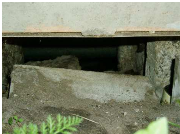
Maja ääres esineb pinnase vajumist ning ühes kohas kassidele auk keldrisse, kus taga paistab ka veetoru.
