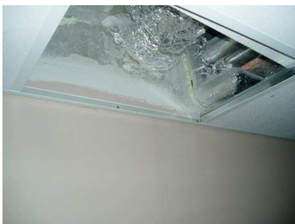
Joonis 20.2 Ventilatsioonitorustiku juurest esineb sadevee läbijookse.
