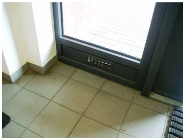
Joonis 8.2 Žalusiirest välisukses.
