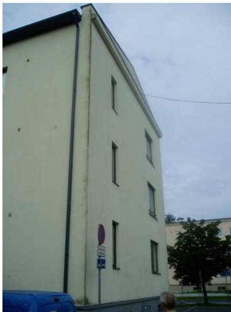
Joonis 18.2 Nurkadel niiskuskahjustused.
