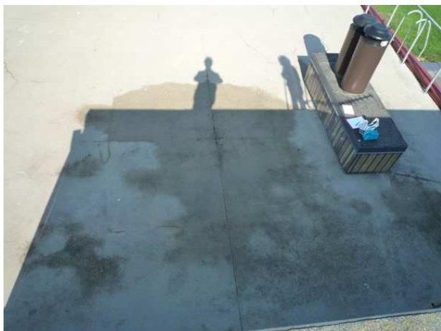
Betoonist (praguline) katuseosa. Sadeveetorul on sõel puudu.
