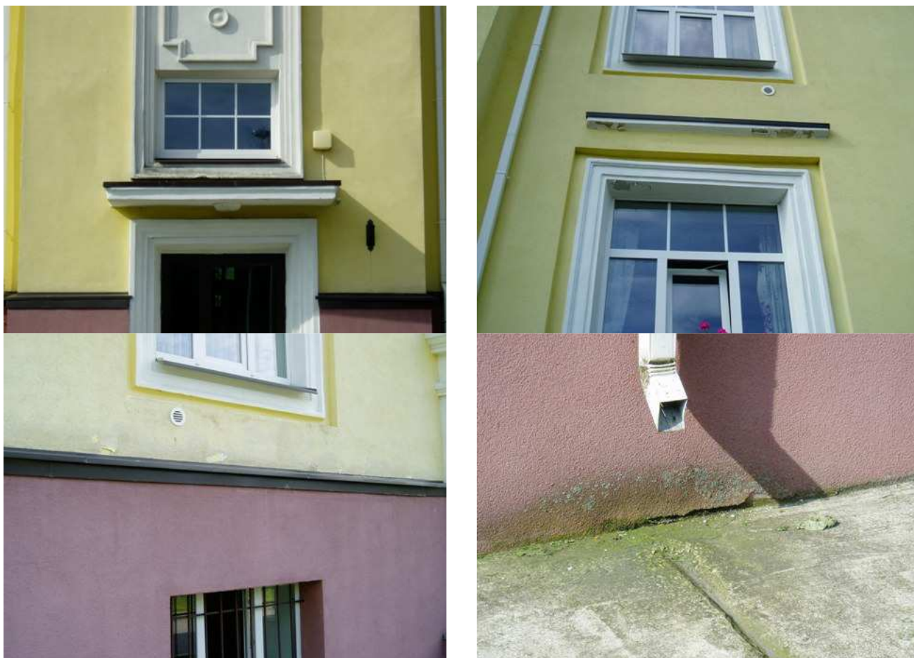
Joonis 13.2 Niiskuskahjustused.
