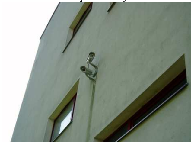
Valvekaamerate tõttu niiskuskahjustused korhvil.
