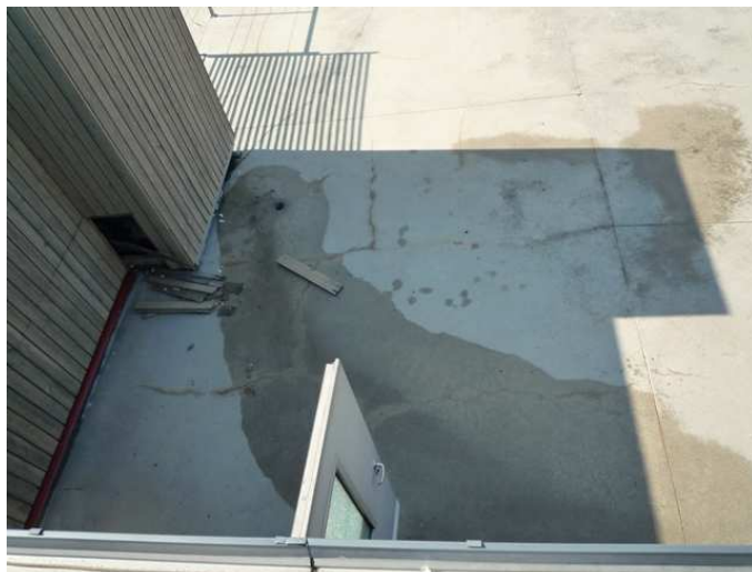
Betoonist (praguline) katuseosa. Sadeveetorul on sõel puudu.
