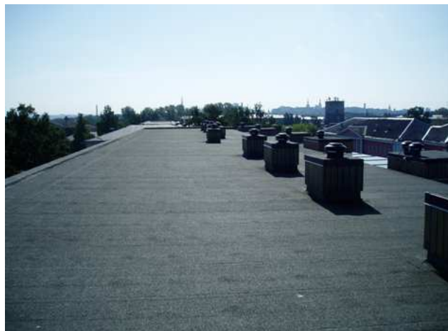
Joonis 2.3 Erika 9 katuseventilaatorid.
