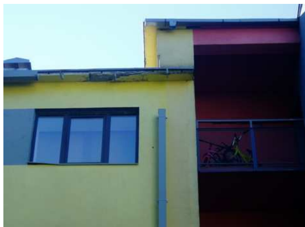
Lume sulamine ja jää teke räästas on põhjustanud vihmaveerennide ja räästa kahjustused.
