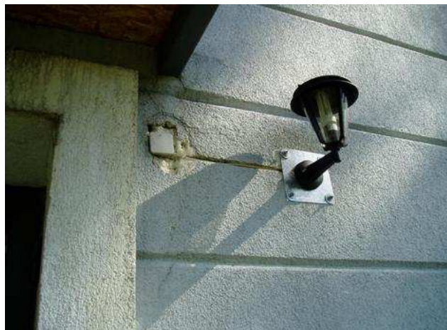
Välisvalgustuse paigaldamisel ei ole fassaadikate taastatud.
