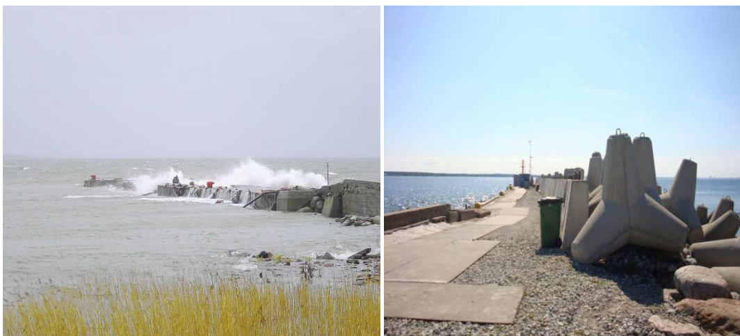
Joonis 4. Vasakul: olemasoleva kai olukord pärast 2005. jaanuari tormi. Paremal: olemasoleva kai hetkeolukord augustis 2010 (Allikas: Tallinna Kommunaalaamet ja Ramboll Eesti AS)
