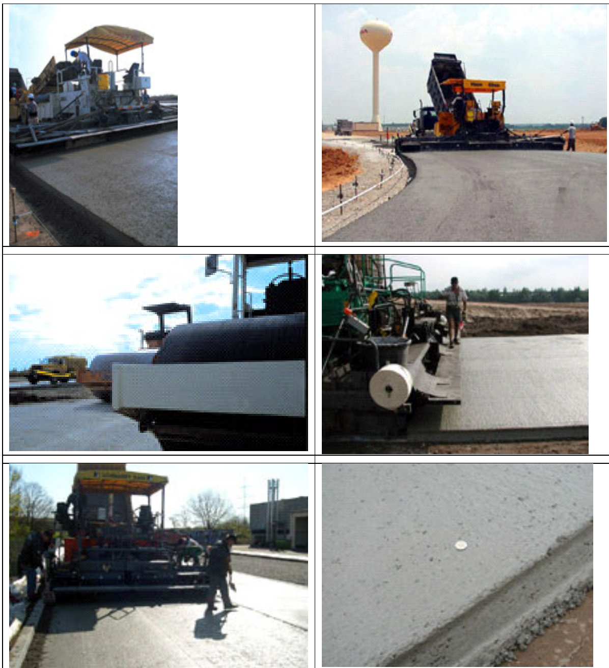
Joonis 3.7. Rullitud tsementbetoonkatted - Roller-Compacted Concrete – RCC
