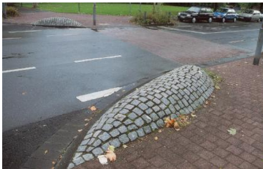
Joonis 6.30 – Võimalik lahendus kergliikleja sõiduteele minemise tõkestamiseks
