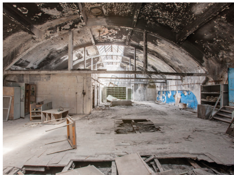
Illustratsioon 34 - Vaade Põhjala tehase I löövi teisele korrusele
