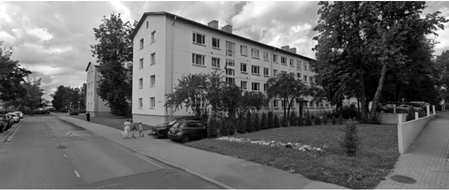
Illustratsioon 59. Vaade Vindi tn 9 korterelamule. Kuvatõmmis Google Earth, (vaadatud 5. III 2026)
