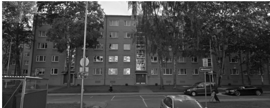
Illustratsioon 56. Vaade Vindi tn 9 korterelamule. Kuvatõmmis Google Earth, (vaadatud 5. III 2026).
