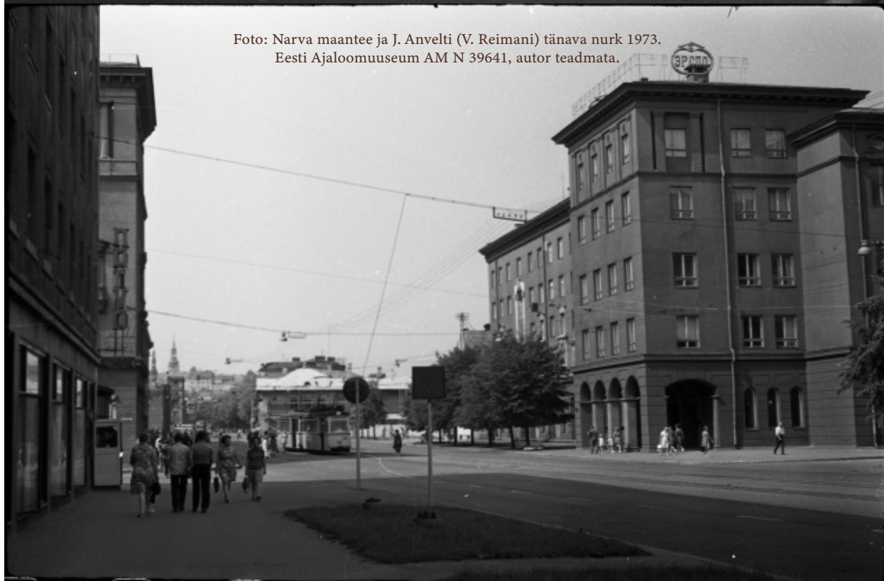
Foto: ETKVL / Tsentrosojuzprojekti maja, vaade hoonele. Eesti Arhitektuurimuuseum EAM Fk 12277, aasta ja autor teadmata.
