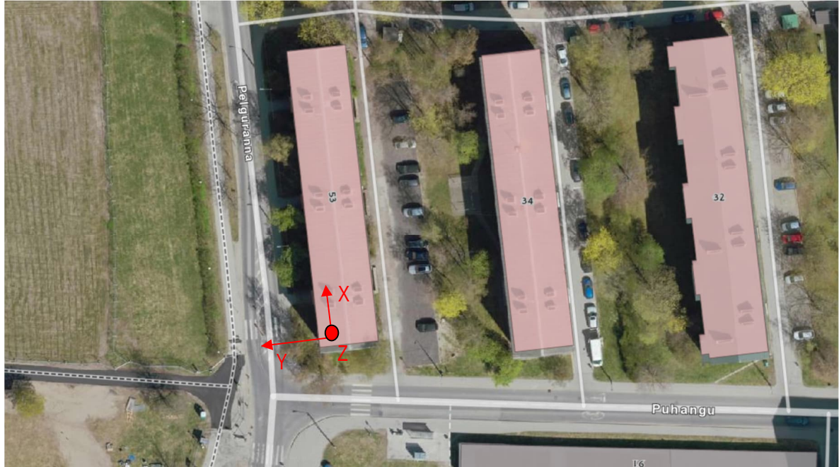
Pilt 1. Vibratsiooni mõõtmise ajal paigaldatud vibratsiooniandurid korteri nr 34 magamistoas
