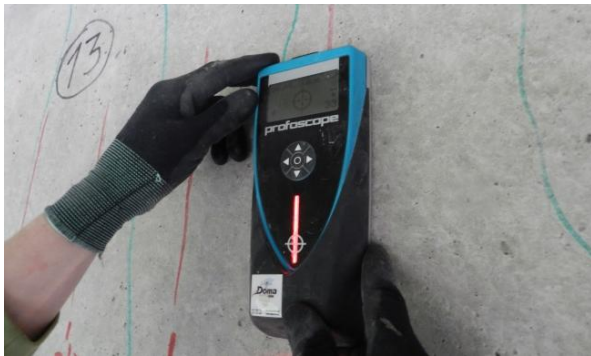
Foto 4. Terrassarruse paiknemine, betoonist kaitsekihi mõõtmine ja varda läbimõõdu määramine seadmega Proceq Profoscope+
