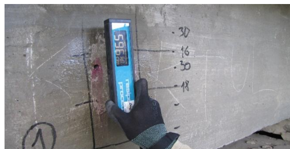
Foto 6. Sarruse korrosioonitase mõõtmine seadmega Proceq Resipod
