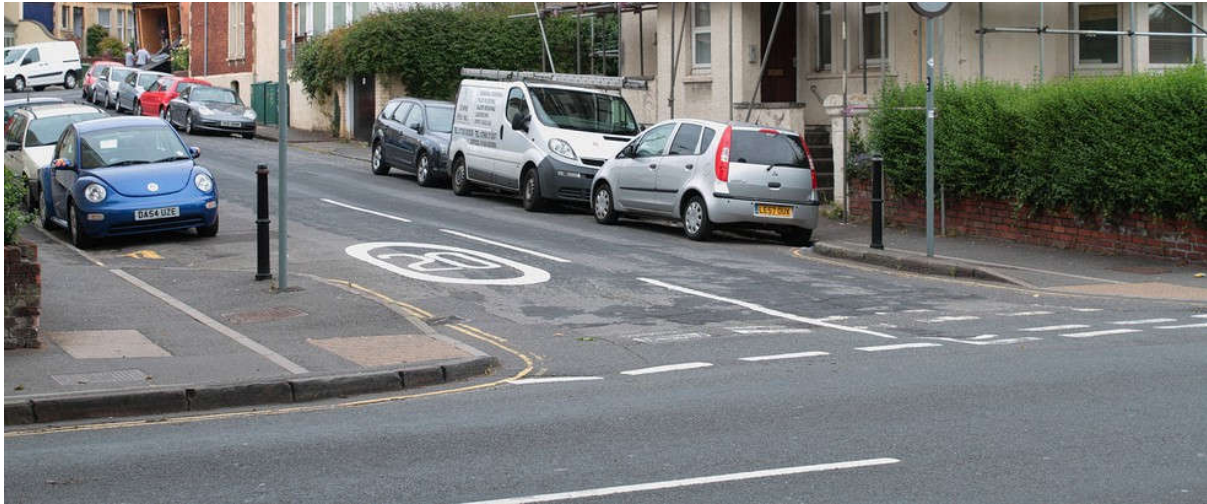
Joonis 37 Parkimist taksitav ja nähtavust tagav ristmiku kitsendus. (Allikas: https://www.trafficchoices.co.uk/traffic-schemes )
