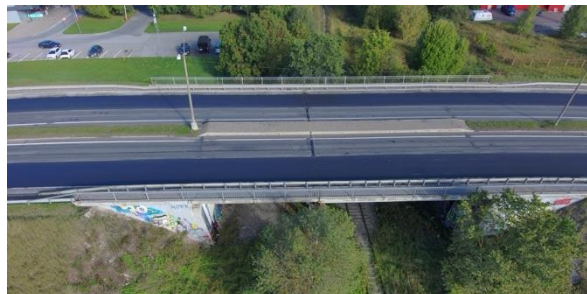
Foto D.1. Vesse viadukt
