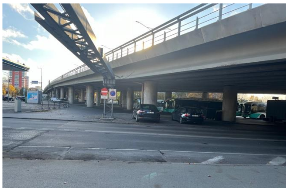
Foto E.3. Pärnu mnt viadukt üle raudtee
