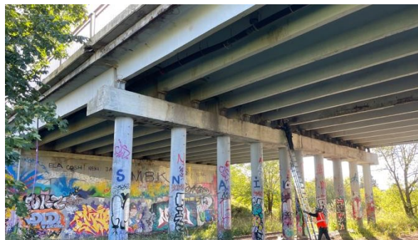
Foto D.3. Vesse viadukt
