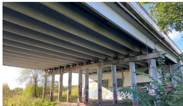
Foto D.4. Vesse viadukt
