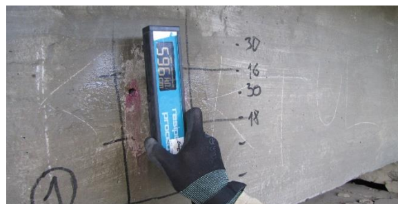
Foto 6. Sarruse korrosioonitase mõõtmine seadmega Proceq Resipod
