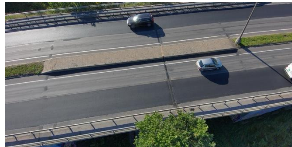
Foto D.2. Vesse viadukt
