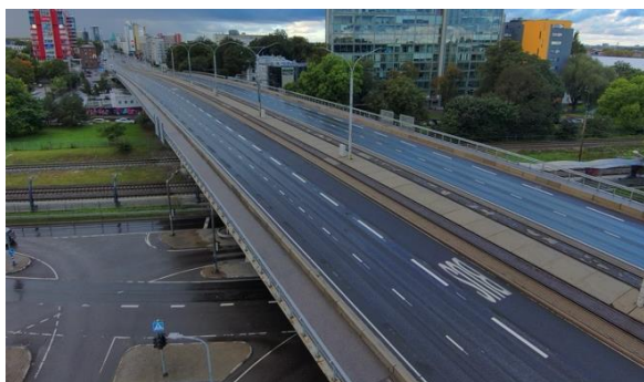
Foto E.1. Pärnu mnt viadukt üle raudtee
