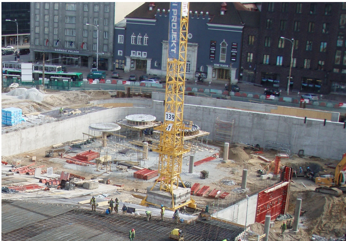
Foto 16 (Kandepostide valamine. Ehitusaegne foto).
