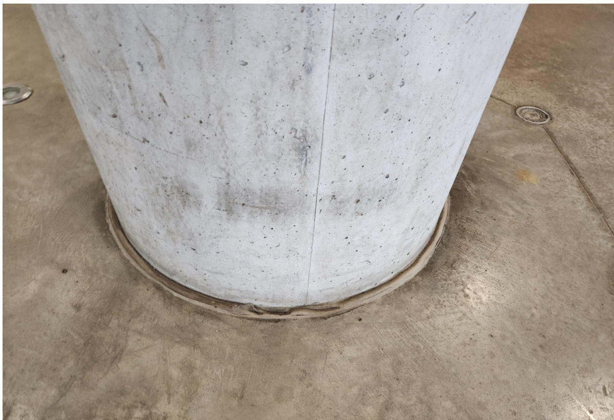
Foto 23 (Kandeposti ja põranda liitumine. Põrand on samas tasandis).
