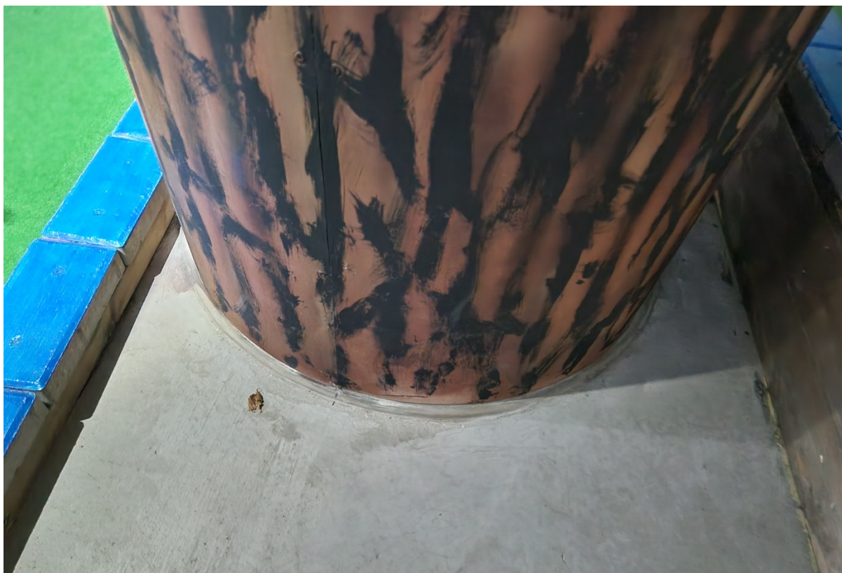
Foto 25 (Kandeposti ja põranda liitumine. Põrand on samas tasandis).
