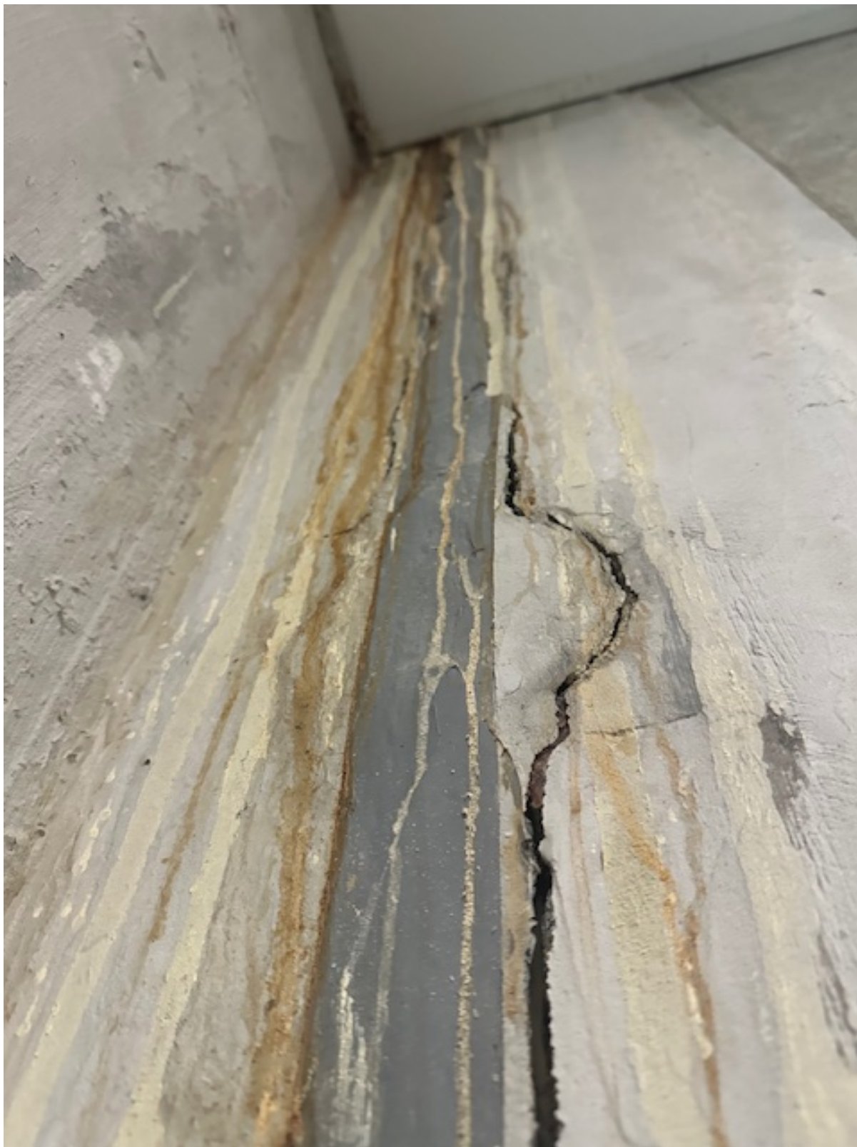
Foto 13a Tuvastatud pragu parkla ja Vabaduse välja trepistiku vahel, mis ei asetse uuritava katendi ala all ega ole sellega seotud. Nimetatud pragu on tekkinud lokaalselt ja ei ole
