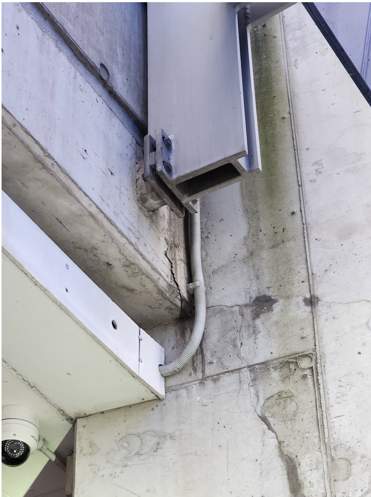
Foto 13 (Vabaduse väljaku eelpingutatud vahelaie kihis seintega liitmise kohas tekkinud praod). Pildil on näha norm suurust (0,4 mm) ületav pragu eelpingutatud vahelaie plaadi ääre ja seina liitumiskohas. Uuringu käigus analüüsiti selle prao võimalikku ohtlikkust ja nenditi et pragu ei läbi olulisi kandevtsoone . Kuna lagi ja sein on analüüsi põhjal valatud erinevatel aegadel, siis on antud pragude iseloom ilmsesti mahukahanemislik, pragu tekkinud raketise ehitamisega lõhutud auku jt. Ajaga ei ole see pragu edasi arenenud, ega
