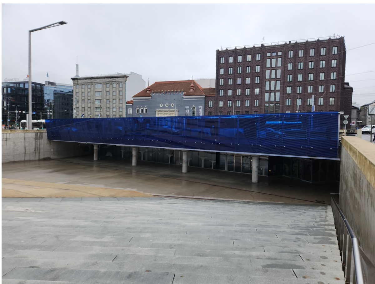
Foto 6 (Vabaduse väljaku maa-aluse parklakorruse eelpingutatud vahelagi).
