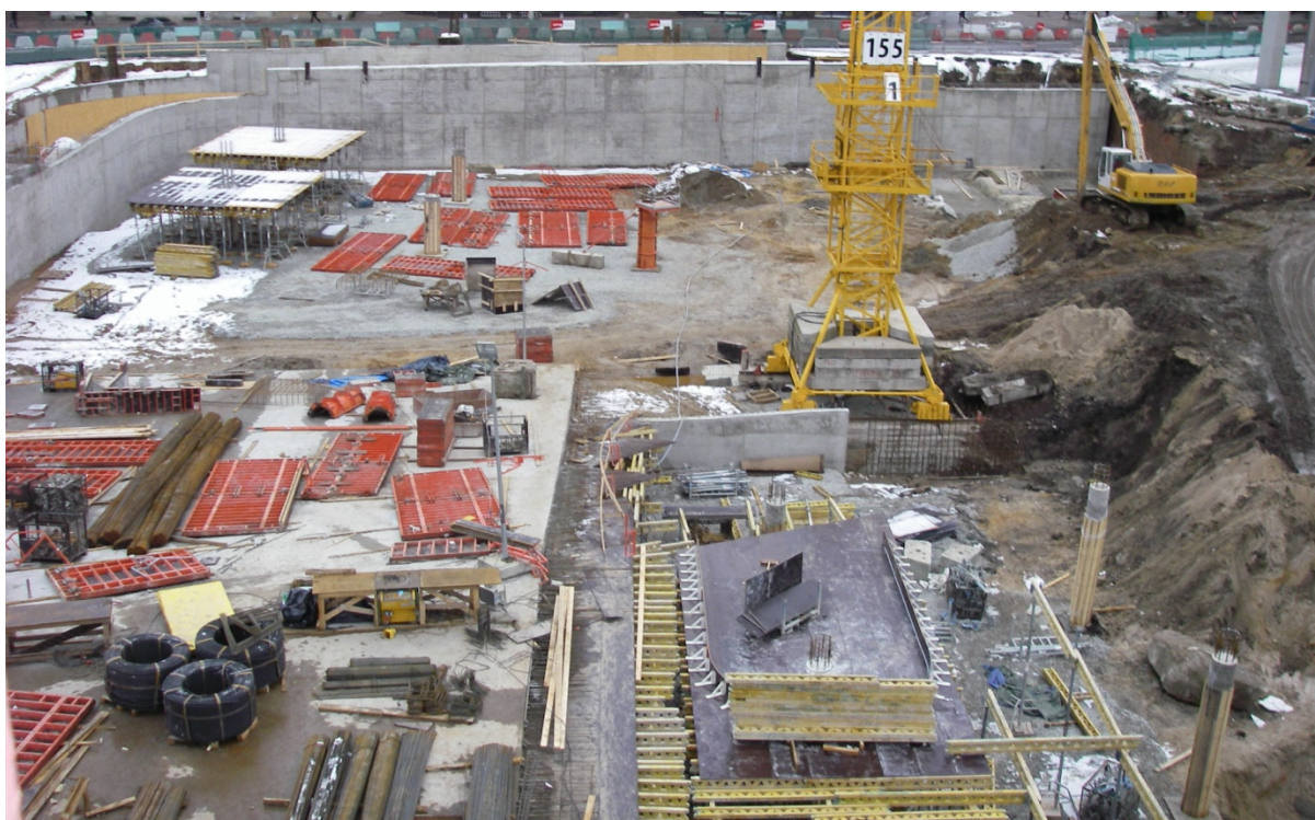
Foto 15 (Kandepostide valamine. Ehitusaegne foto).
