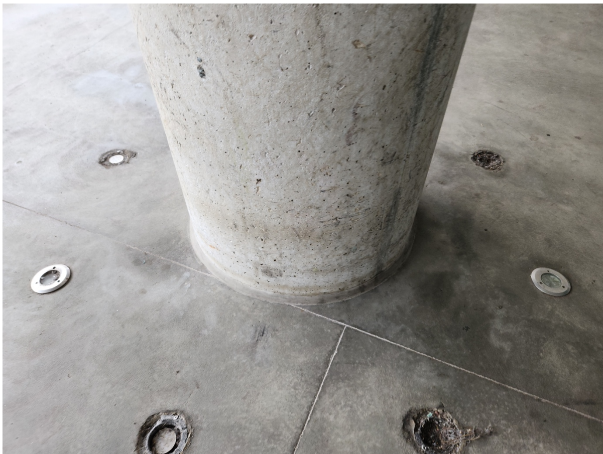
Foto 22 (Kandeposti ja põranda liitumine. Põrand on samas tasandis).
