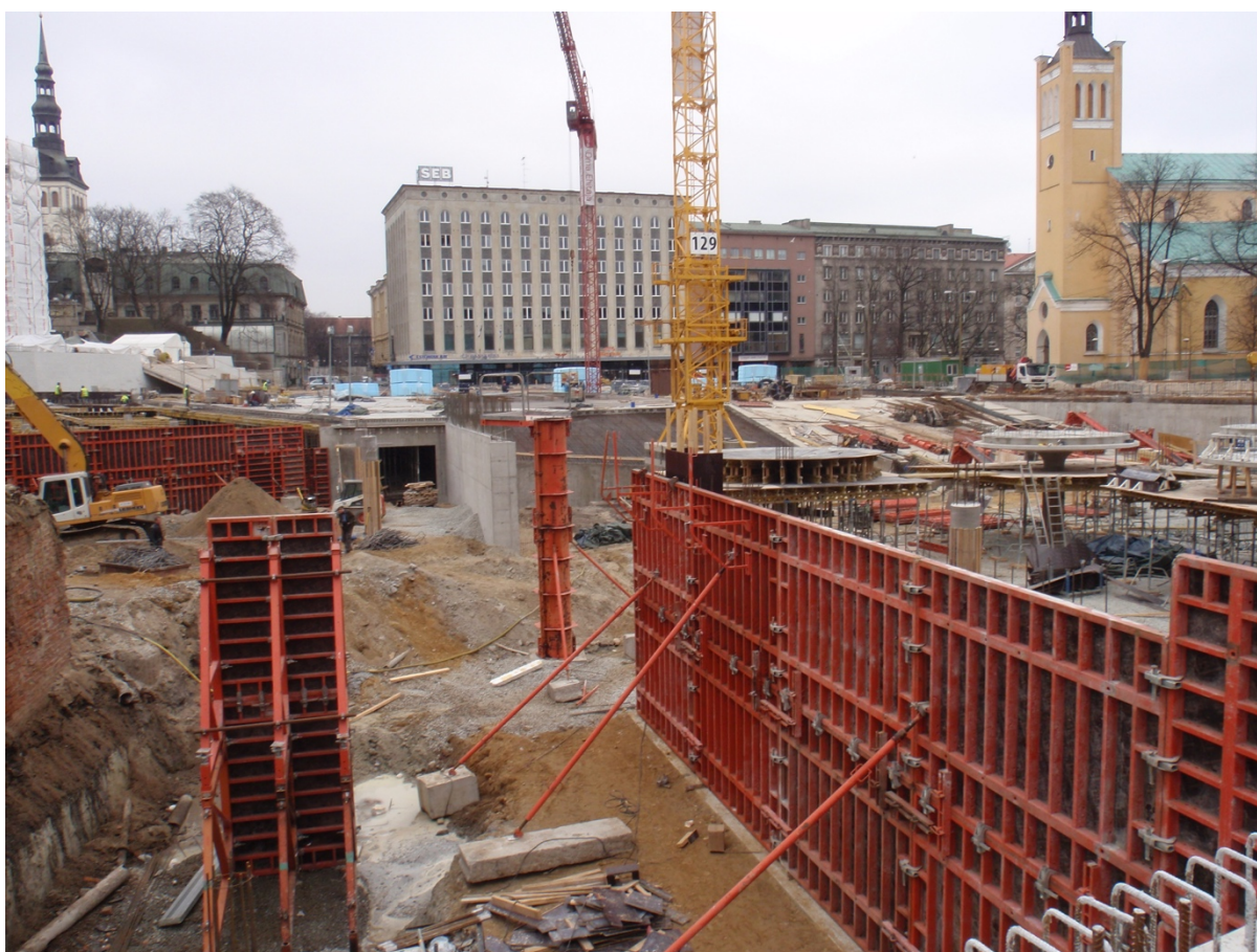
Foto 17 (Kandepostide valamine. Ehitusaegne foto).
