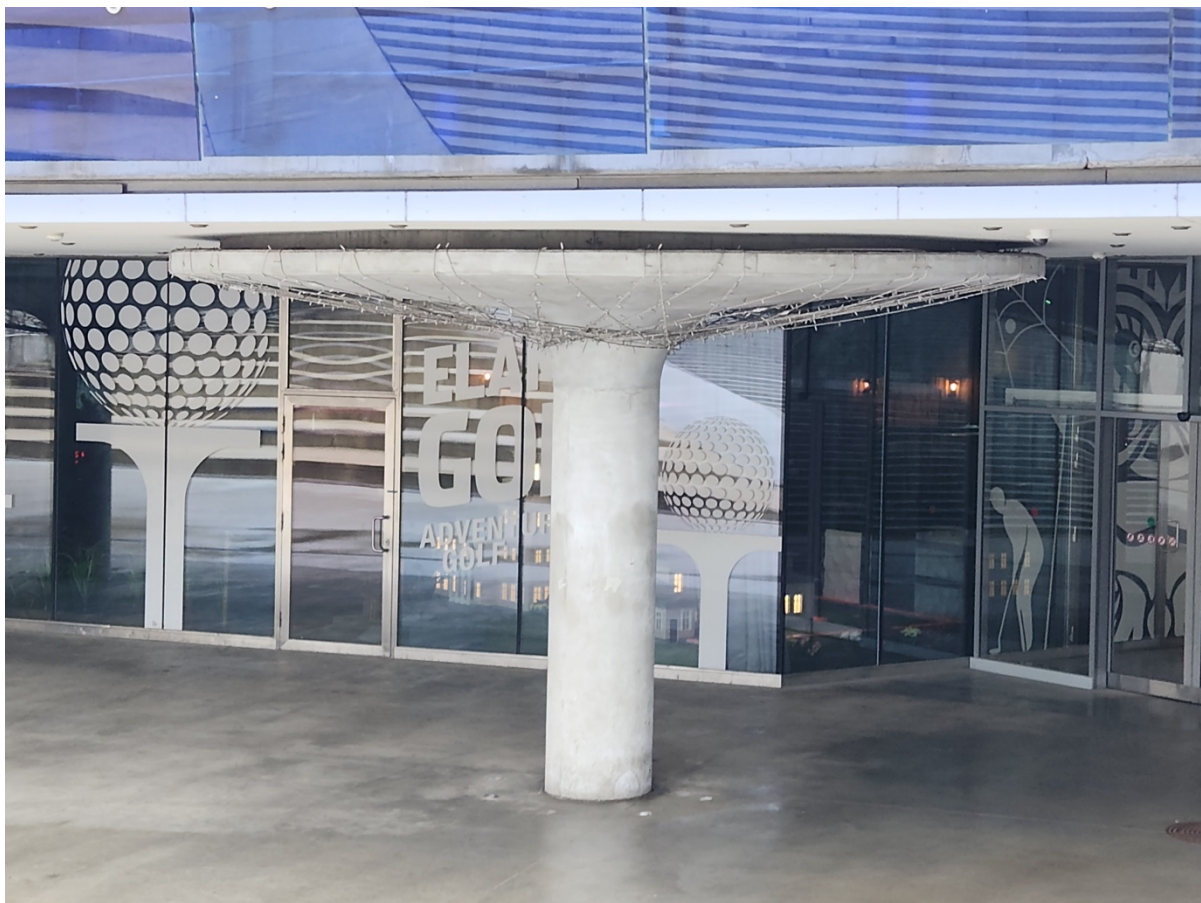
Foto 14 (Eelpingutatud vahelae kandepost).
