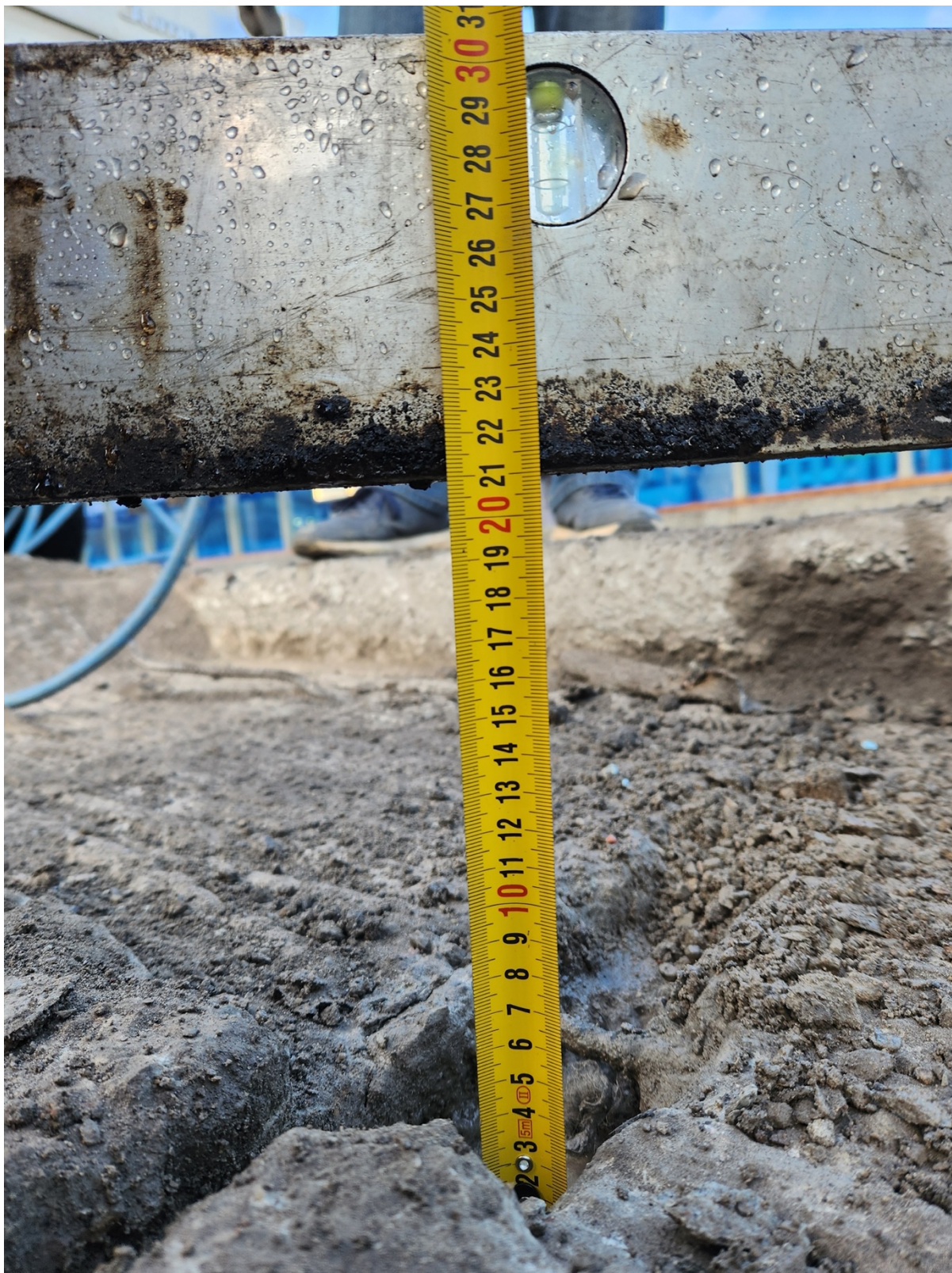
Foto 44 (Surf nr2 sügavus asfaltpinnast kuni soojustuseni)
