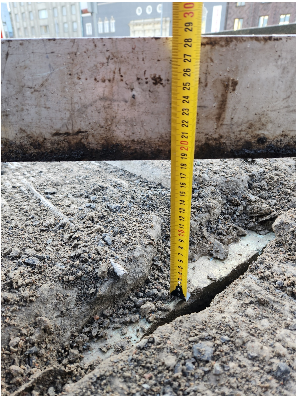
Foto 30 (Surf nr1 sügavus asfaltpinnast kuni soojustuseni).
