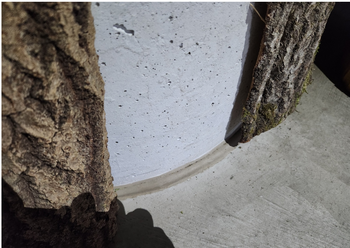
Foto 24 (Kandeposti ja põranda liitumine. Põrand on samas tasandis).
