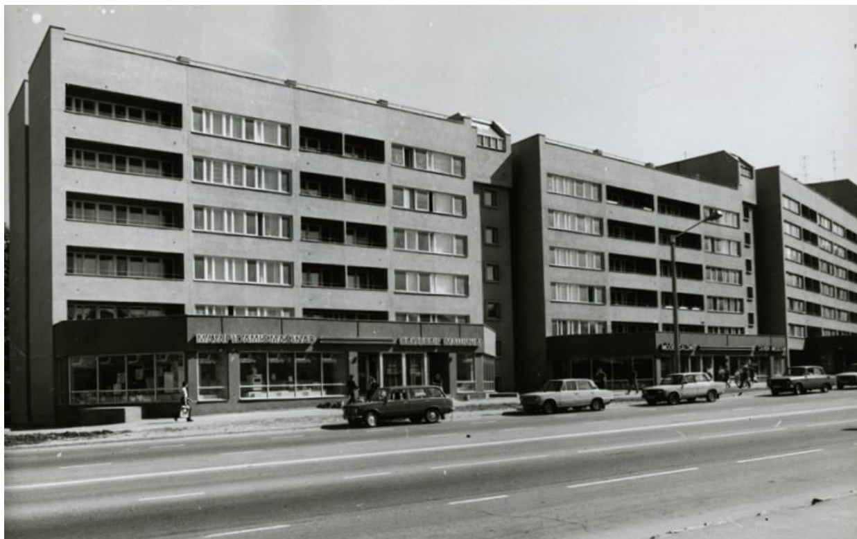
Liivalaia 40 tänaväärne fassaad varsti pärast valmimist. Foto Eesti Arhitektuurimuuseum
