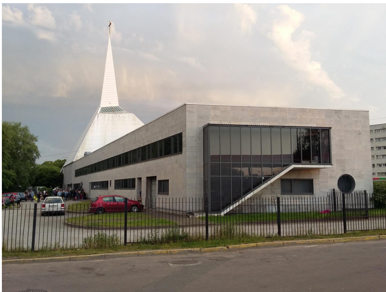
Metodisti kirik hilises suveõhtus. Esiplaanil koguduseruumide ja kontorimaht. Autori foto 2020
