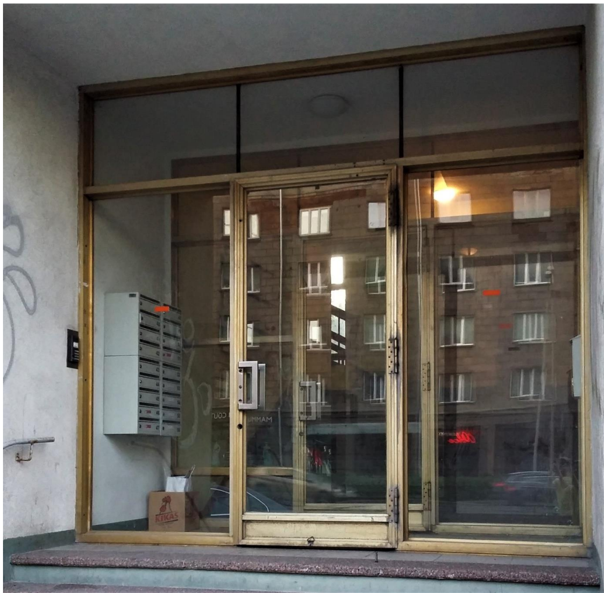
Üks trepikojasissepääsudest Liivalaia 29 peafassaadil. Autori foto 2020
