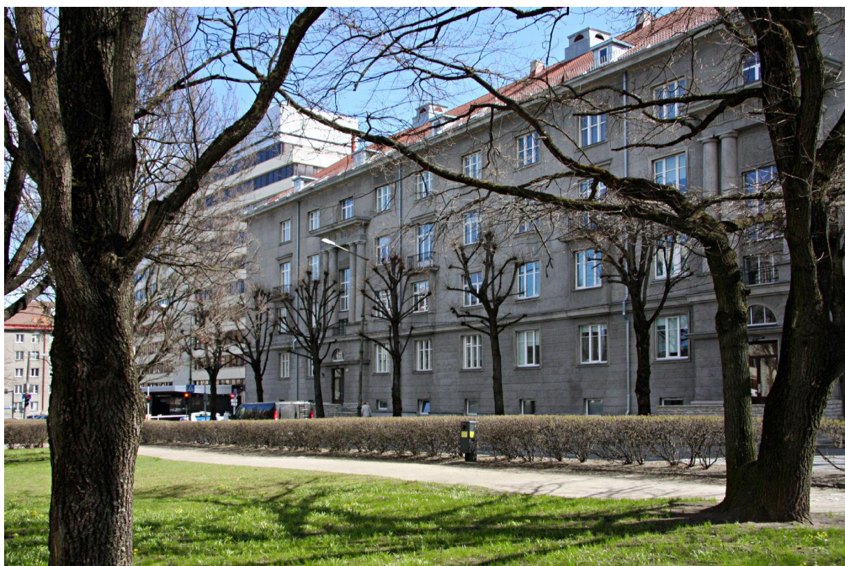
Rävala puistee haljastus varakevadel. Foto City24
