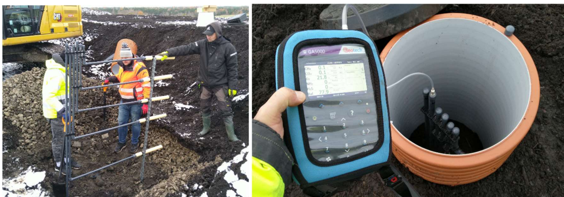
Joonis 6. Gaasikaevu paigaldamine ja näide gaasi mõõtmisest kaevus
