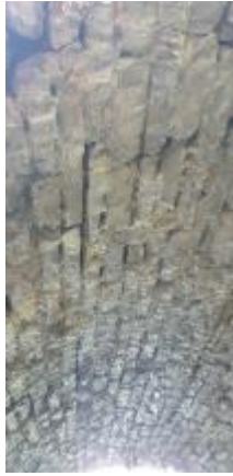
Monoliitne r/b plaat
