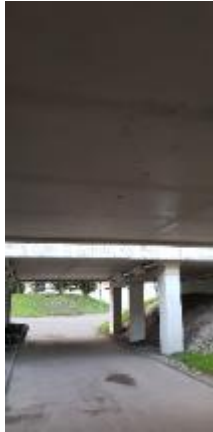
Monoliitne r/b plaat
