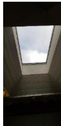
Monoliitne r/b plaat
