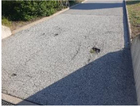
Tunneli põrand || Mustamäe poolse rambi asfaltkattes sügavad augud ja võrkpraod
