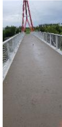
Monoliitne r/b plaat
