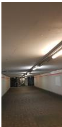
Monoliitne r/b plaat
