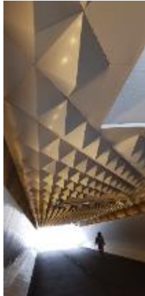
Monoliitne r/b plaat
