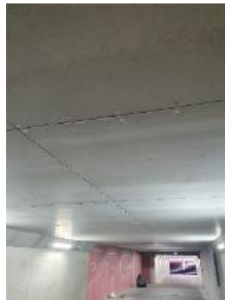
Monoliitne r/b plaat
