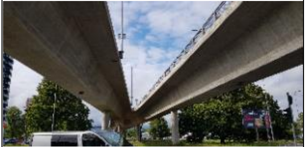
Monoliitne r/b plaat
