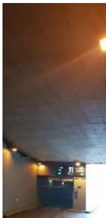
Monoliitne r/b plaat
