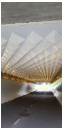
Monoliitne r/b plaat
