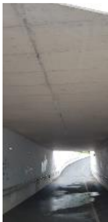
Monoliitne r/b plaat
