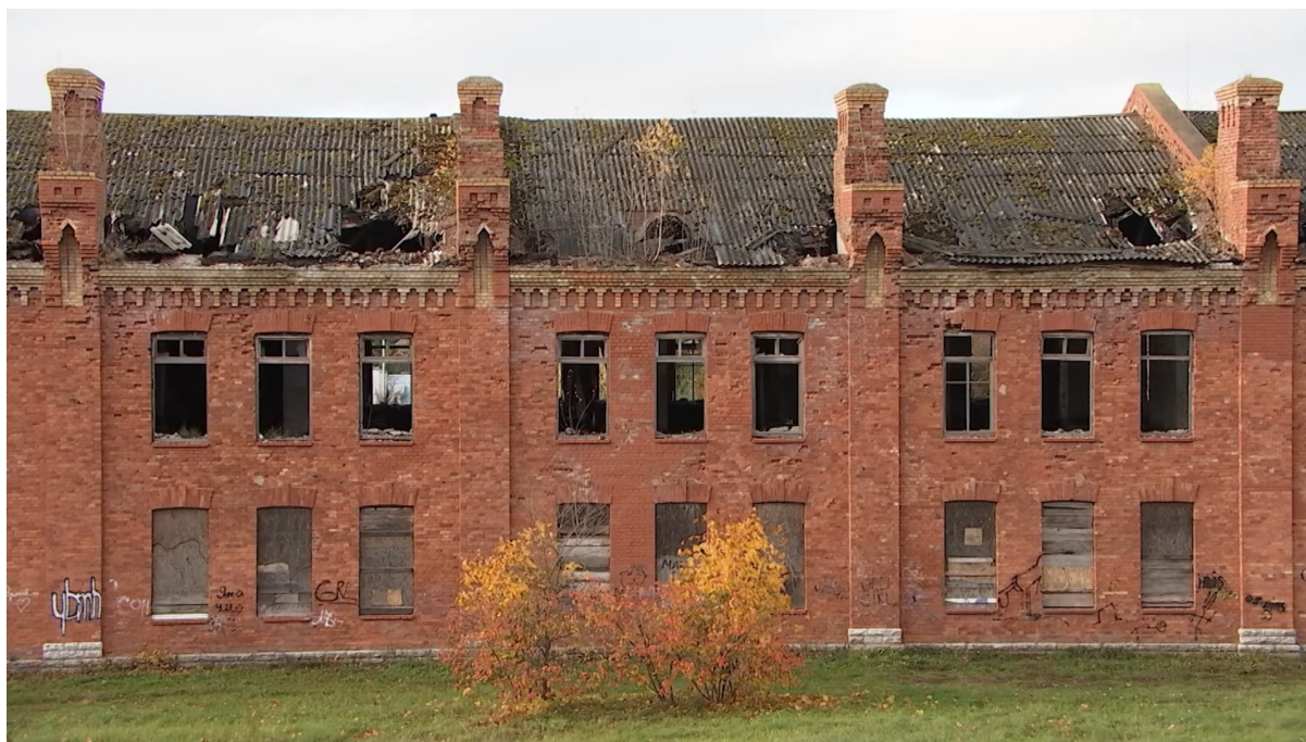
Illustratsioon 28. Vaade Tondi 53 kasarmu fassaadile.
