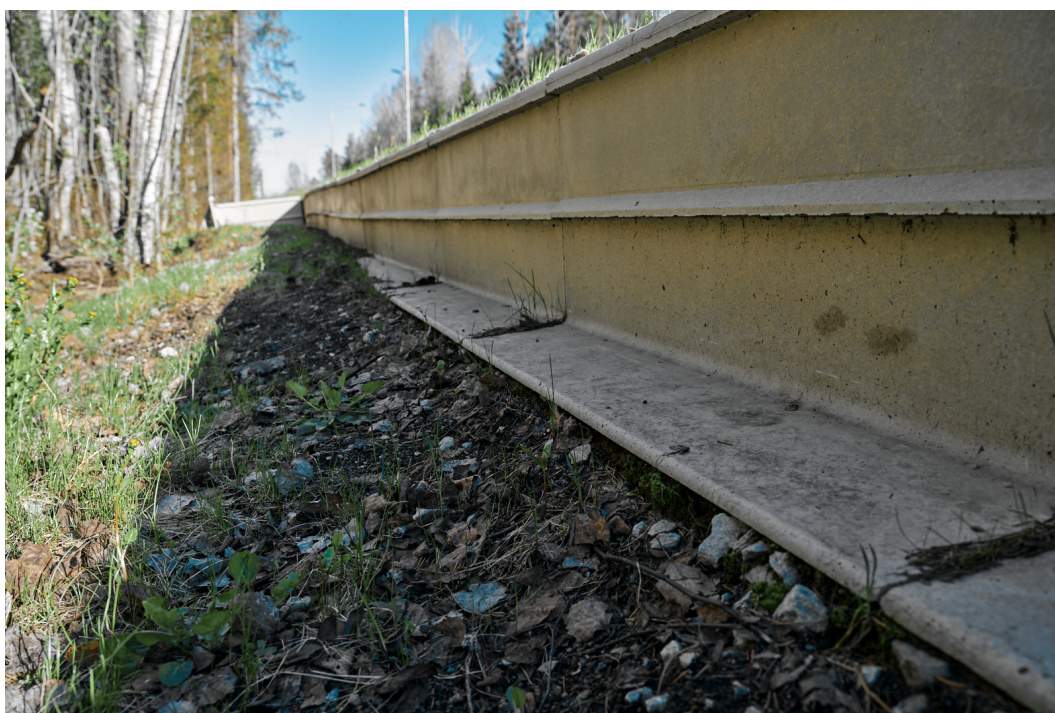
Foto 9. Tänavast põhja pool on tõkke B alt pinnas minema kandunud. Kui pinnas tõkke alt kaob kukub tõkke lõik lahti ning tõkke lakkab sihipäraselt toimimast. Vajalik on tõkke alune taas täita. Foto: J. Remm.
