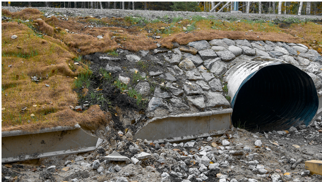
Foto 8. 2020 aasta oktoobris toimus tunneli B juures väike tõkke lagunemine. Õnneks parandati tõkke kohe ning hiljem ei ole lagunemine edasi arenenud. Foto: J. Remm.
