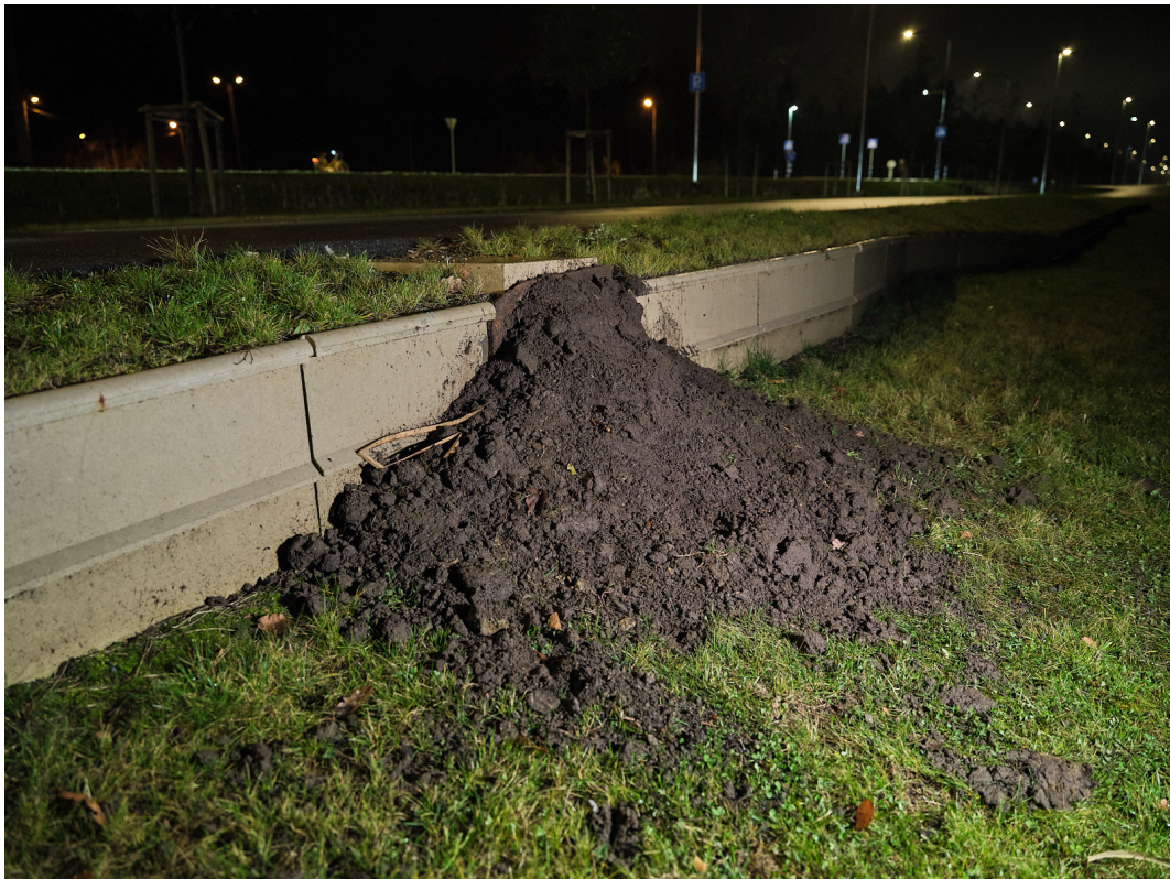
Foto 10. Viimasel vaatlusringil 2022. aasta oktoobri lõpus leiti, et tunnel C on põhjapoolses otsas suletud ehitusplaadi ja mullaga. Niiviisi on takistatud loomade läbipääs tunnelis ning ronides üle mullahunniku pääsevad loomad teele. Kuigi tunneli sulgemise motiiv ei ole teada, on tegemist taunitava juhtumiga. Foto: J. Remm.
