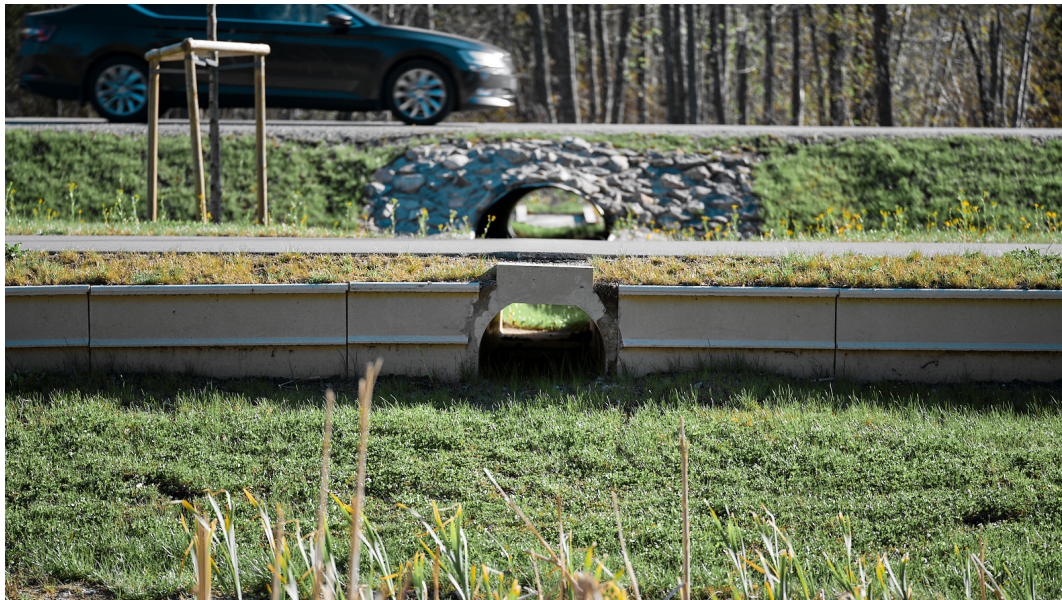
Foto 1. Tõkete ja tunnelite süsteem C. Esiplaanil on näha komposiitmaterjalist tõkked ja väiksem tunnel kergliiklustee all, tagaplaanil on suurem terastorust tunnel sõidutee all; vaade lõuna suunas. Foto J. Remm.
