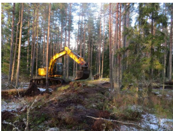
Foto 7. 15 tonni kaaluva ja 1,5 m laiuste lintidega ekskavaator tüübile 2 vastava paisu rajamisel Laukasoo, Lahemaa rahvusparkis. Kahel ülemisel pildil toimub paisu kehandi rajamine, alumistel piltidel paisu katmine mätastega. Ühe paisu rajamine kestab ligikaudu 1 tund. Foto: J.-O. Salm
