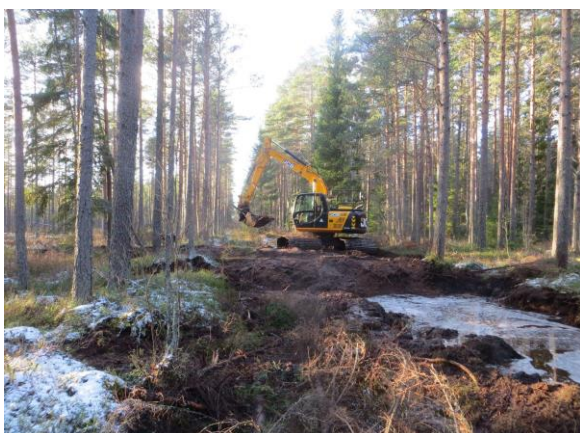
Foto 7. 15 tonni kaaluva ja 1,5 m laiuste lintidega ekskavaator tüübile 2 vastava paisu rajamisel Laukasoo, Lahemaa rahvusparkis. Kahel ülemisel pildil toimub paisu kehandi rajamine, alumistel piltidel paisu katmine mätastega. Ühe paisu rajamine kestab ligikaudu 1 tund. Foto: J.-O. Salm
