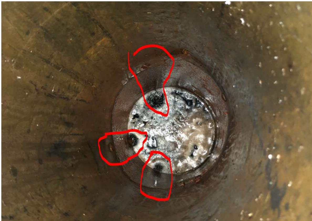
Foto 3. Drenaažikihis kogunenud puhas vesi voolab teleskoopitoru vahelt nõrgvee drenaažikaevu
