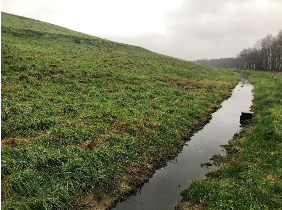
Foto 12. Nõrgveega täitunud sisemise kraavi lõik (19.11.2020)
