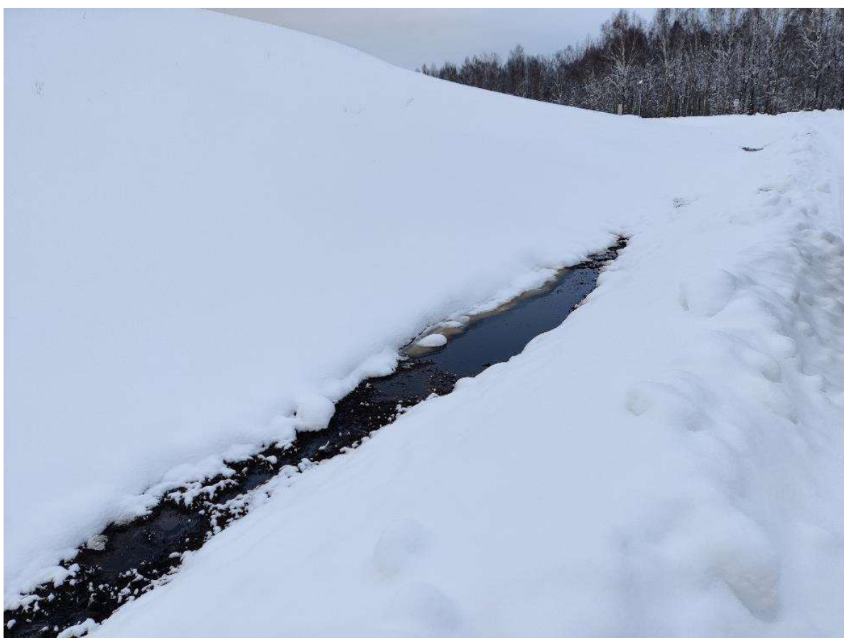
Foto 20. Nõrgveega täitunud sisemise kraavi lõik (03.02.2021)
