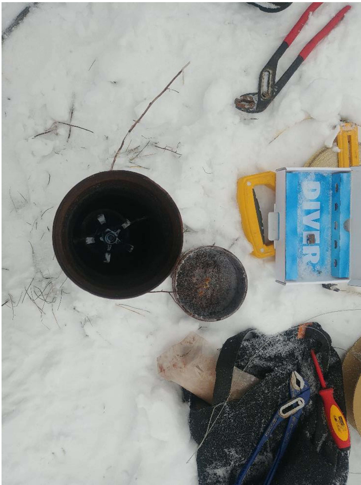
Foto 18. Nõrgvee seirekaevu LW-3 paigaldatud automaatne veetaseme mõõtja ja õhurõhu mõõtja
