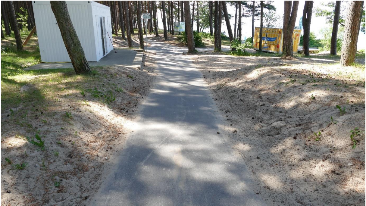
Foto 12. Erodeeruvad kergliiklustee nõlvad HK ala lõunaosas.
