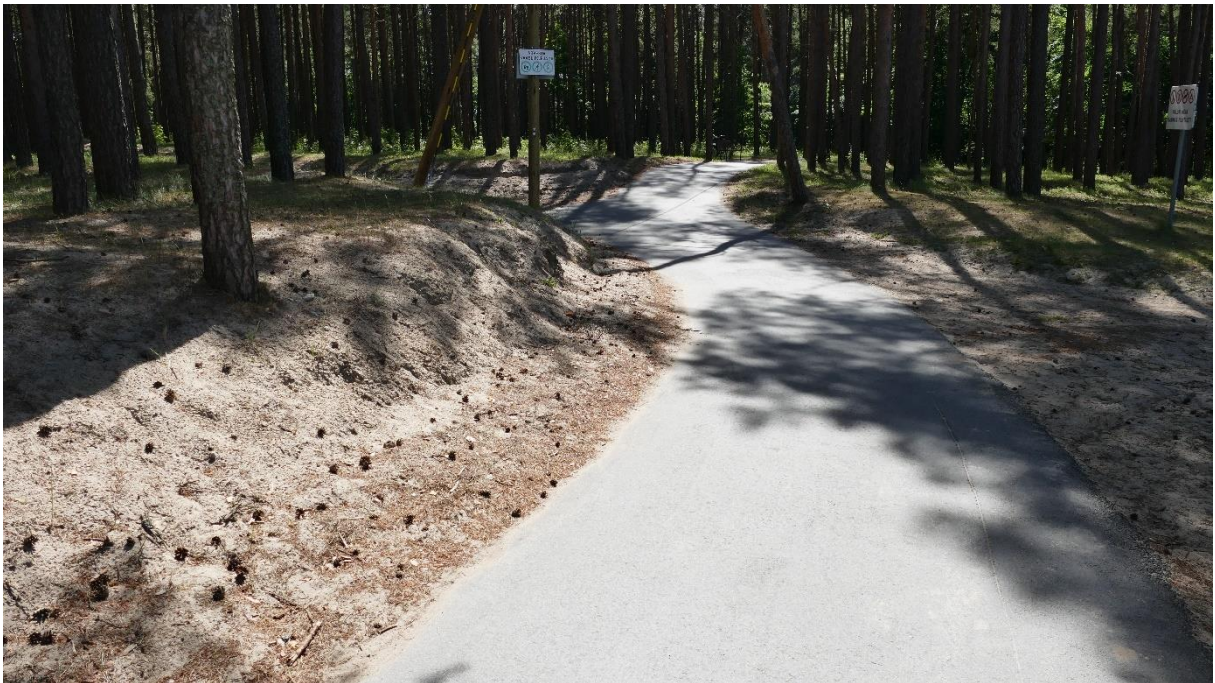
Foto 19. Tee ehituse tagajärjel tugevalt erodeerinud nõlv.
