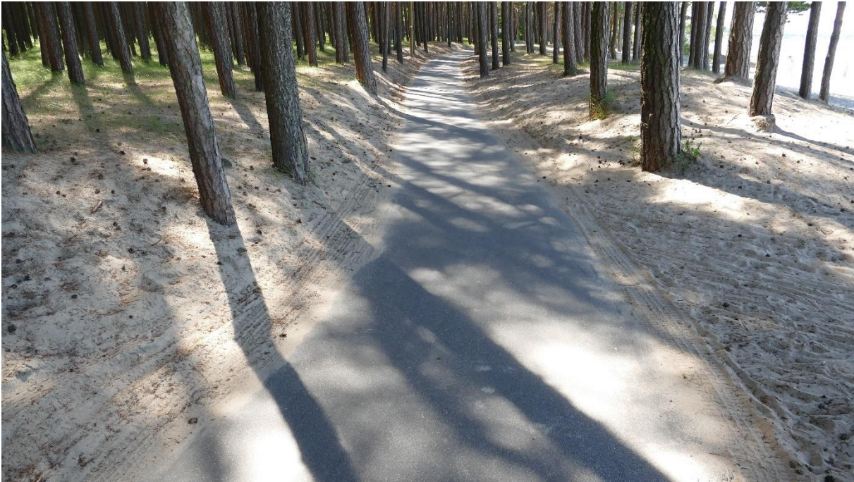
Foto 20. Erosiooni tagajärjel liikuv liiv tekitab deflatsiooni ja raskendab tee hooldust. Probleemsetel lõikudel on vajalik näha ette täiendavad meetmed tee servades erodeerinud alade laienemise peatamiseks.
