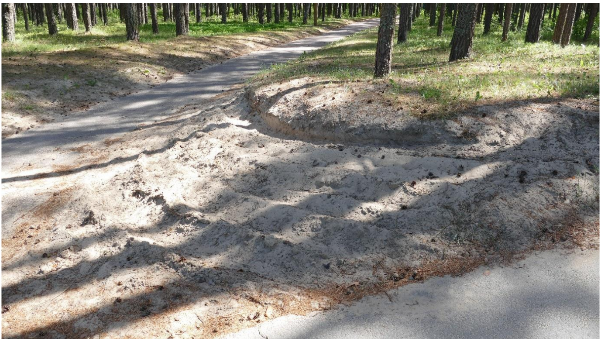
Foto 25. Oletatavasti hooldusmasinate poolt „sirgeks“ sõidetud ristmik, kus erosiooni tõkestamiseks on vajalik pöörderaadiuse piires teekatte rajamine ja nõlva kindlustamine.
