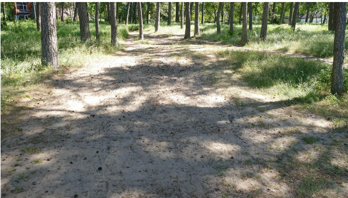
Foto 11. Erodeeritud pinnasetee metsa põhjaosas.
