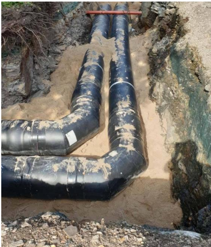
Joonis 2.1. Kaugjahutuse paigaldamine Tartu maanteel
