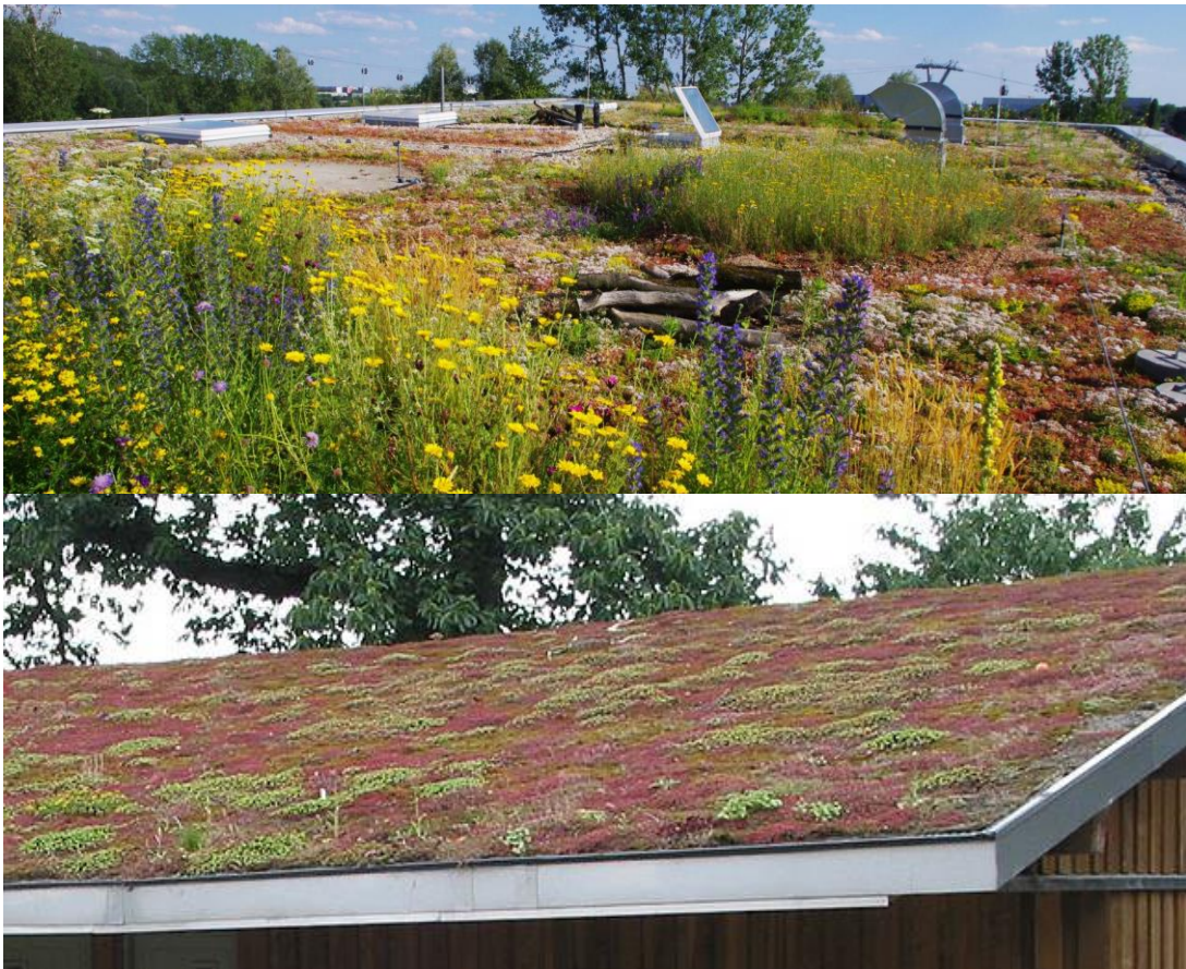
Joonis 20. Üleval tolmeldajate vajadustega arvestav rohekatus (Foto: ZinCo) ja all madala haljastusega rohekatus (Foto: Pauline Eccles).
