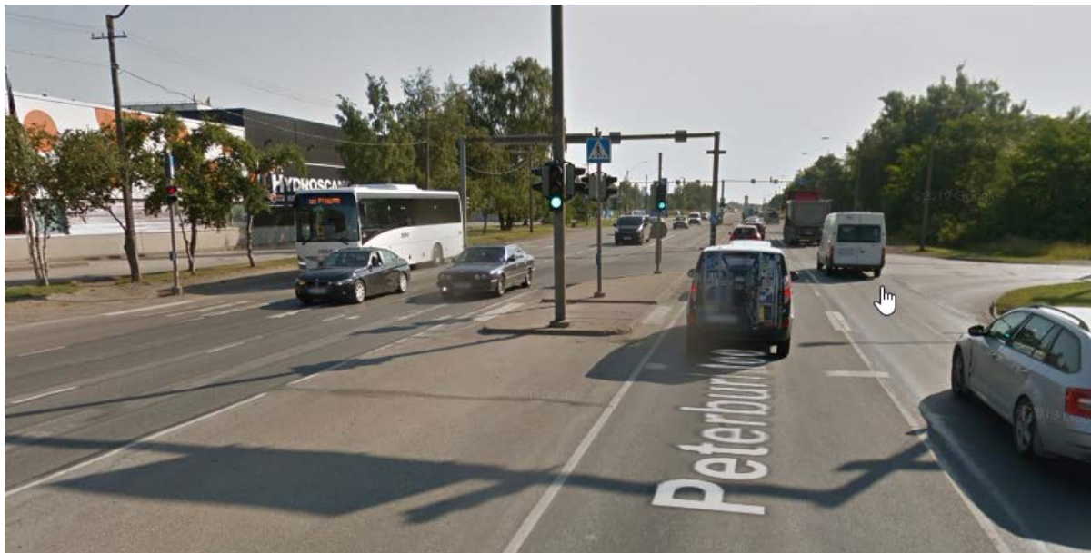
Joonis 9. Kulunud teekattemärgistus, nõuetele mittevastav jalakäijate reguleeritud ülekäik
