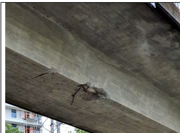
Liikluskahjustused talal, niiskuskahjustus tekiplaadil
