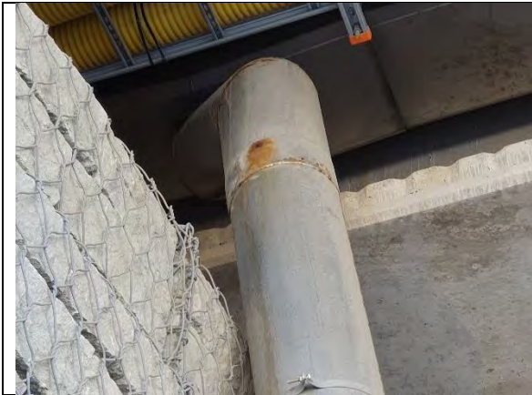
Joatoru korrosioon
