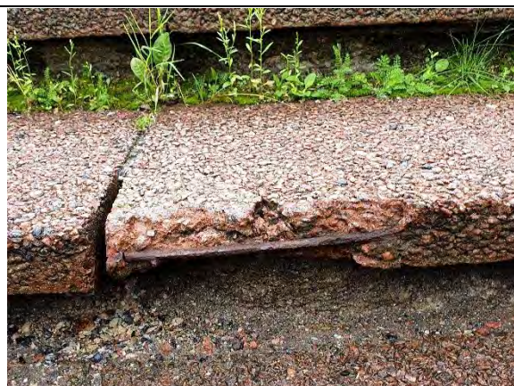
Trepikonstruktsioon laguneb
