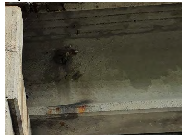
Tekiplaadileke kahjustab talade kahjustusi
