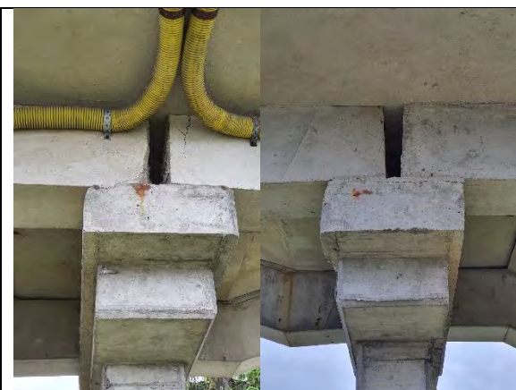
Praad trepikonstruktsioonides
