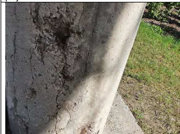
Sõiduteelt pritsiva soolvee põhjustatud sambapostide kahjustused
