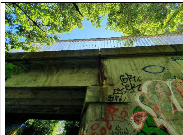
Vuugileke põhjustab kandesammaste kahjustusi
