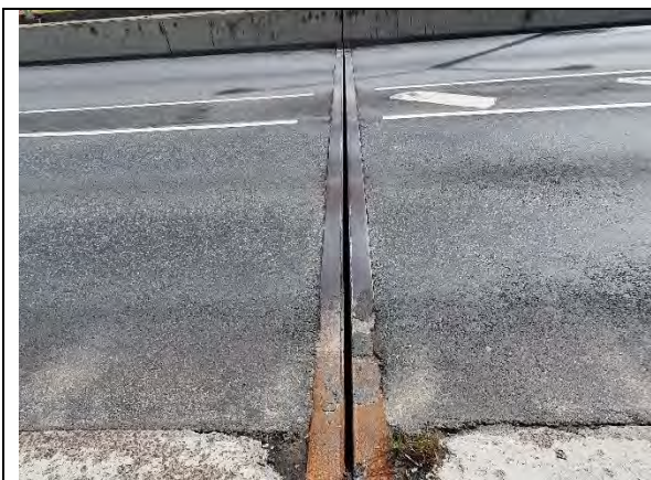
Lekkiv vuuk põhjustab betoonpindade kahjustusi.
