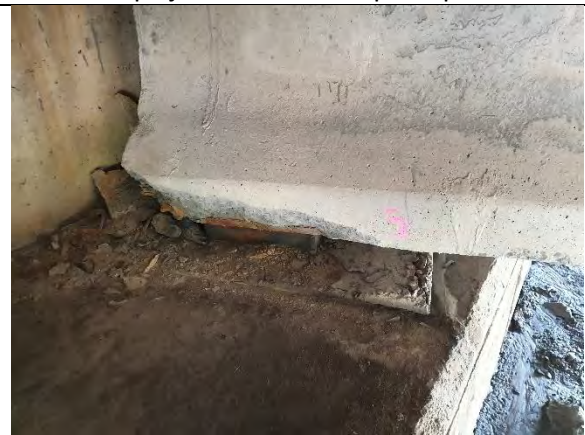
Tugipadjad, tugiosad ning tala otsad mõranenud vuugilekkest
