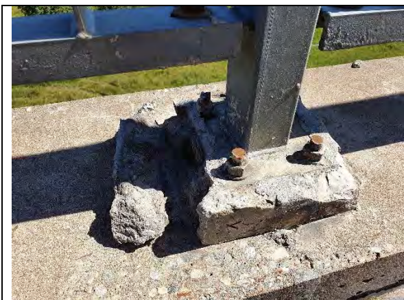
Käsi puu betoonpadjad murenenud
