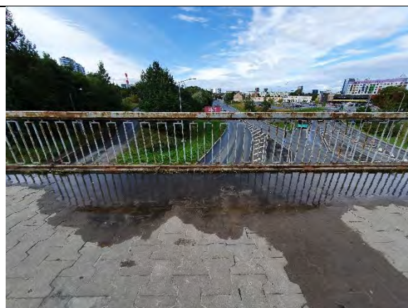
Piirded roostes ja sillutiskivid osaliselt murenenud
