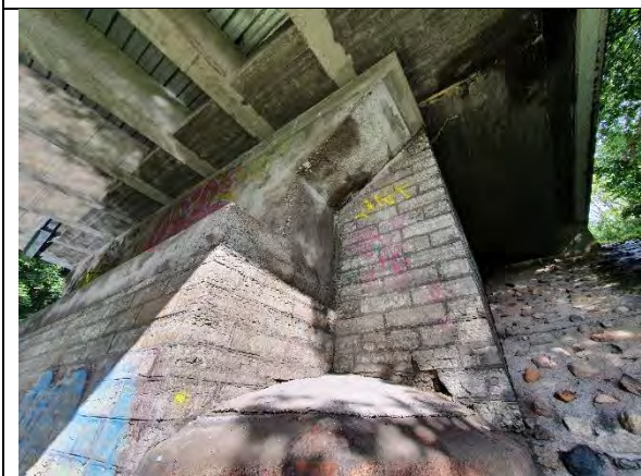
Vuugileke põhjustab tekiplaadi kahjustusi
