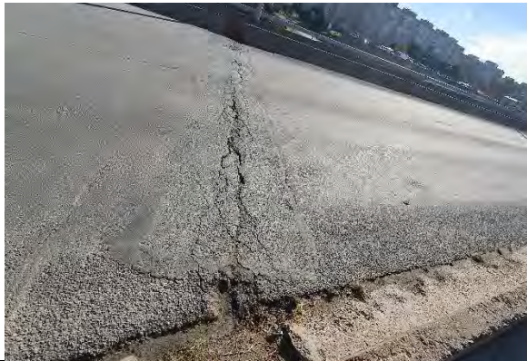
Vuugikonstruktsioonid vajavad väljavahetamist
