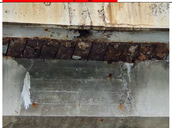
Servaprussileke põhjustab tekiplaadi roostetamist
