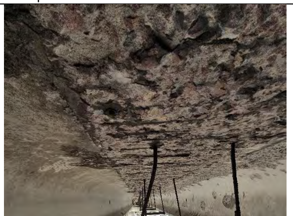
Tekiplaadi armatuur paljandunud
