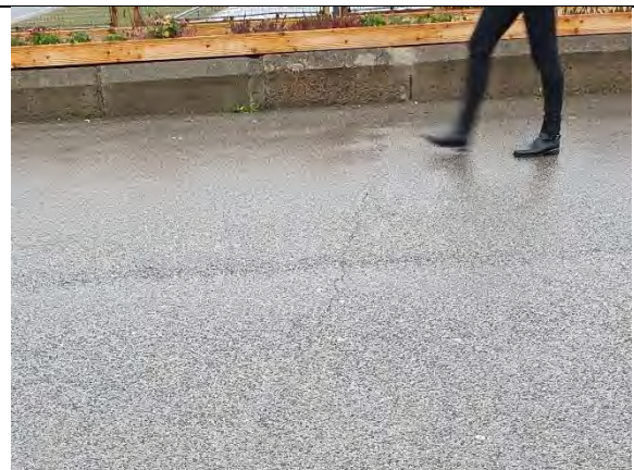
Põikpragu asfaltkihis tala otste kohal
