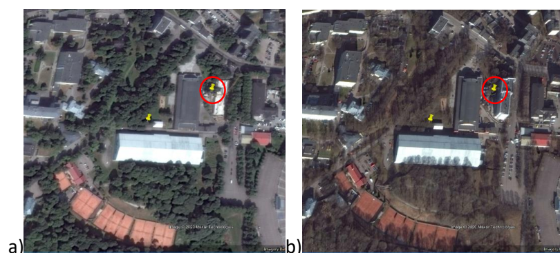
Joonis 9. Maksimaalse hõlbega reeperi nr 269_4 suure liikumise põhjuseks võib olla vahemikul märts.2014 (a) – aprill 2015 (b) reeperi kõrval toimunud ehitustegevus. Antud ajavahemikku PSI analüüs ei katnud ja seetõttu ei kajastunud ka PSI tulemustes. Pildid Google Earth.
