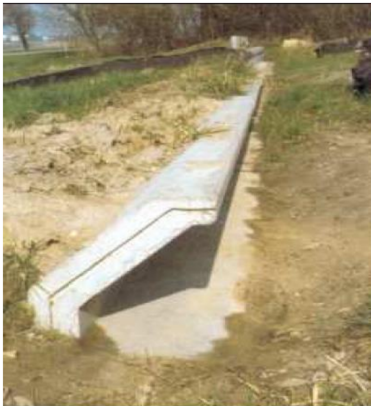
Joonis 9. Kahepaiksetele sobivaim betoonist piire (foto Lars Briggs).
