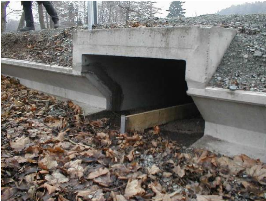
Joonis 10. Kahepaiksetele sobivaim betoondetailidest tunnel. Tunnel on kombineeritud betoonist piirdega. Laud tunneli suudmes aitab loomi tunnelisse suunata (foto Lars Briggs).
