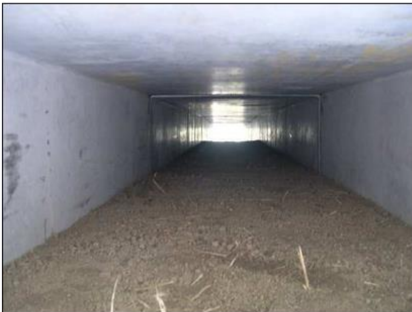
Joonis 11. Kahepaiksetele sobiva tunneli põhi peab olema kaetud pinnasega (foto Lars Briggs).
