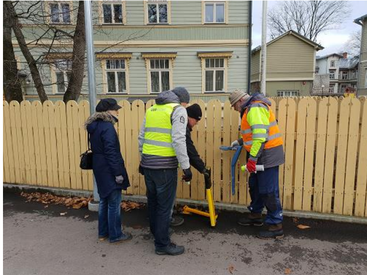
Pilt 25. Tänavavalgustuse kaablite tuvastamine EML-ga Vesivärava tn-l
