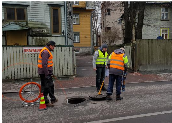
Pilt 26. Sademevee kanalisatsiooni mõõdistamine sondiga Vesivärava tn-l
