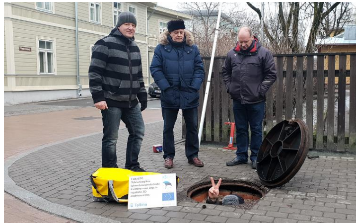
Pilt 27. Sidekanalisatsiooni kaevu uurimine Vesivärava tn-l
