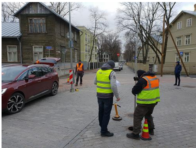
Pilt 28. Kanalisatsioonikaevude uurimine Vesivärava tn-l
